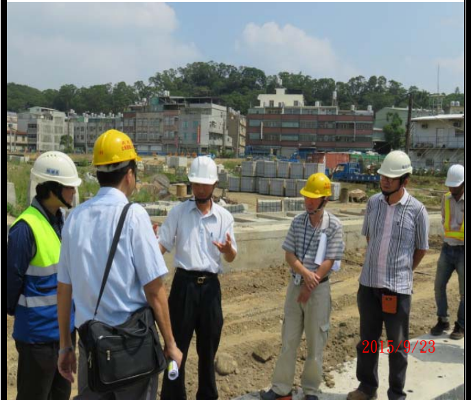
施工督導（工區現場）。
