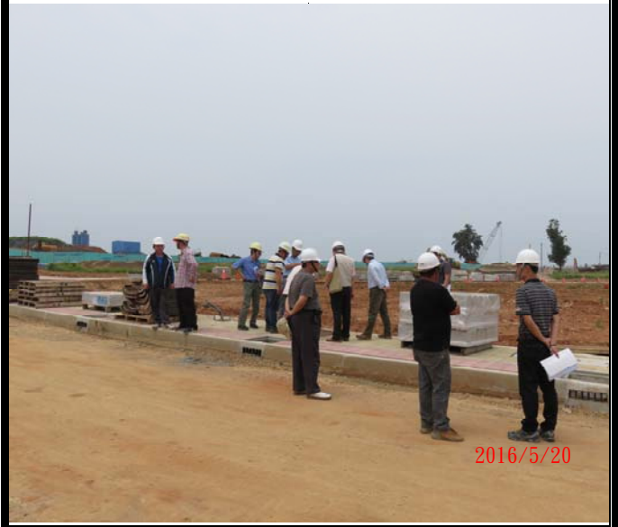
施工督導（工區現場）。
