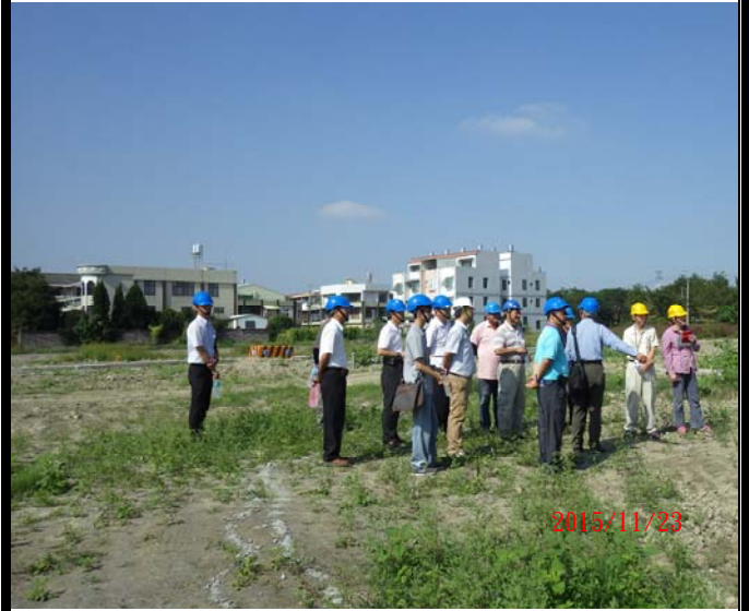
施工督導 (工區現場)。
