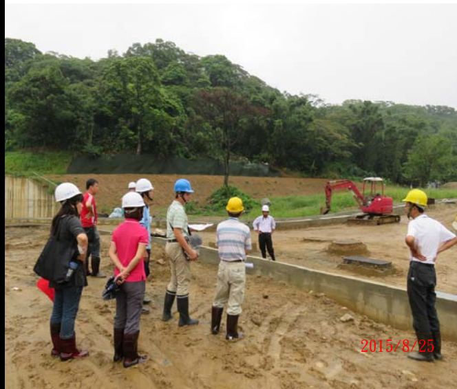
施工督導（工區現場）。
