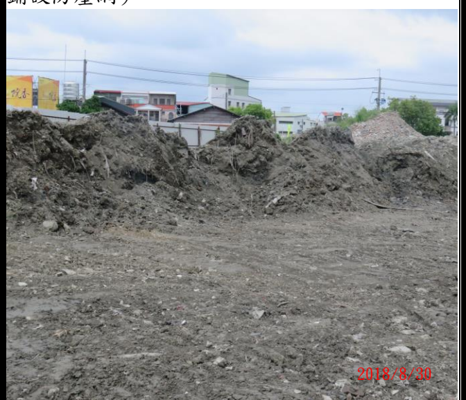
坵塊裸露面及土方堆置區未施作防護措施（如鋪設防塵網）
