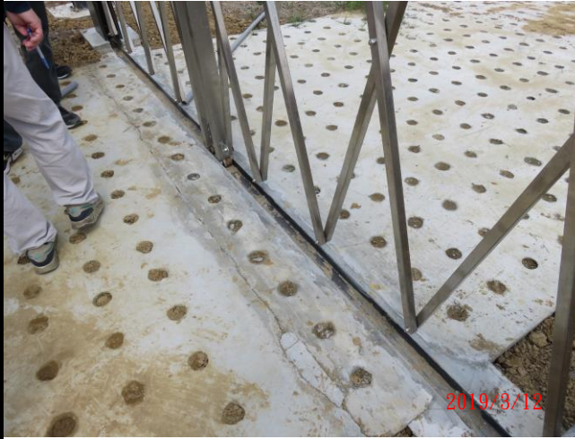
公 34 RC 透水鋪面與活動阻隔措施銜接處收邊有裂縫
