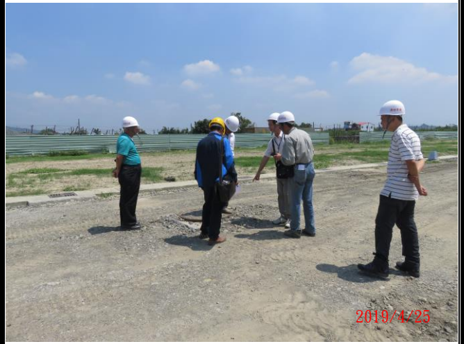
施工督導（工區現場）
