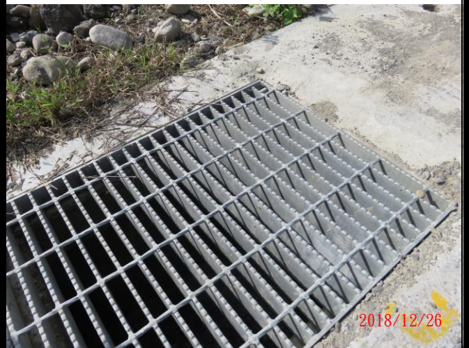
8M-7 道路右側溝清掃孔收邊不平整
