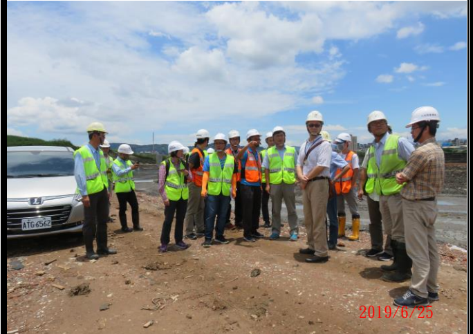
施工督導（工區現場）
