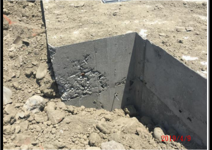
部分已施作側溝表面鐵線未剪除及殘留混凝土蜂窩
