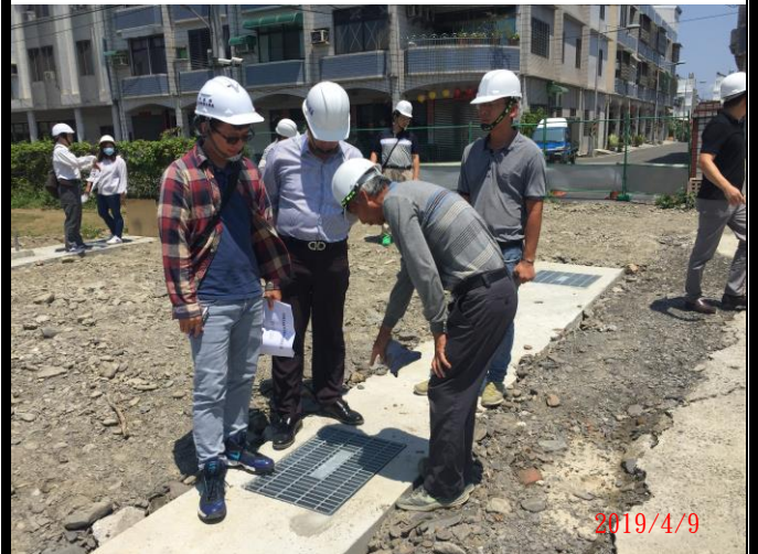
部分已施作側溝表面鐵線未剪除及殘留混凝土蜂窩
