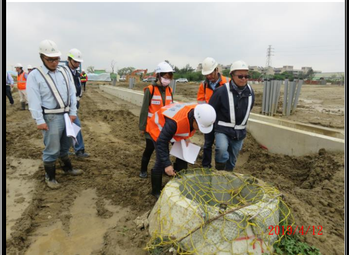
施工督導（工區現場）
