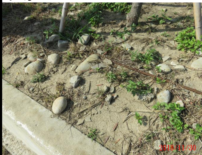
中央分隔島栽種行道樹土壤有大粒徑卵石或混凝土塊
