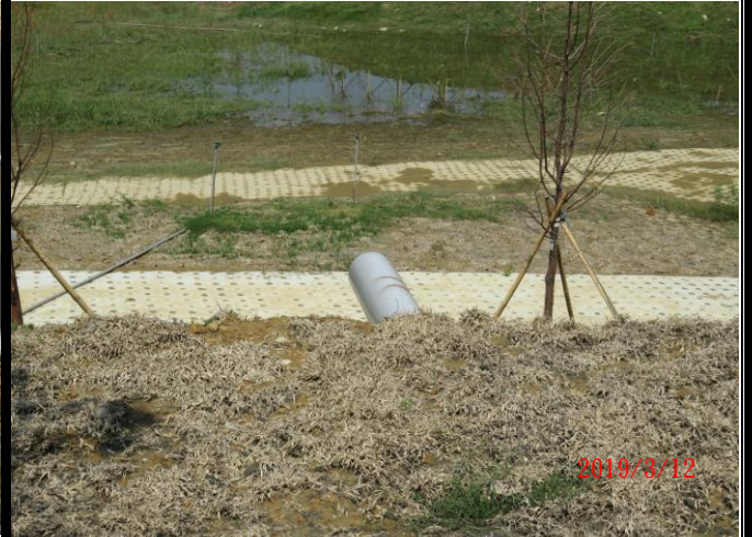
公 34 步道側溝匯流端排入滯洪池之 10" pvc 管凸出土坡未剪除
