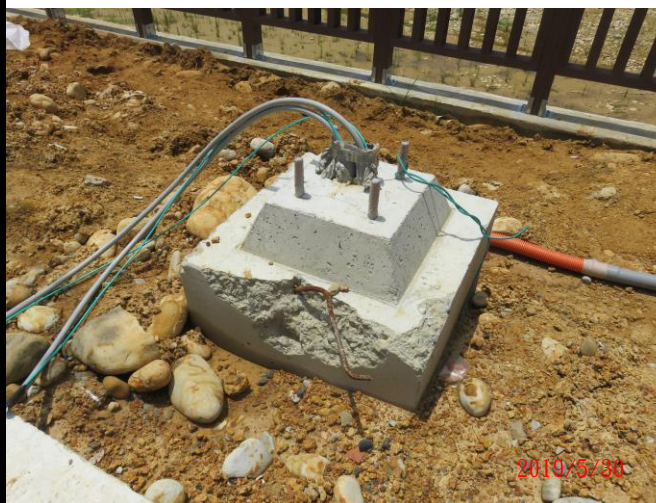
部分路燈基座有破損
