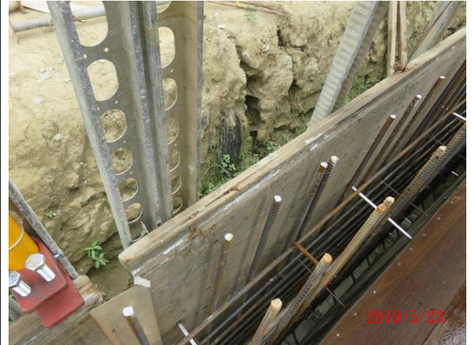
CA02 箱涵側牆模板表面未塗模板油，且模板老舊部分有破損或混凝土殘渣未清除乾淨
