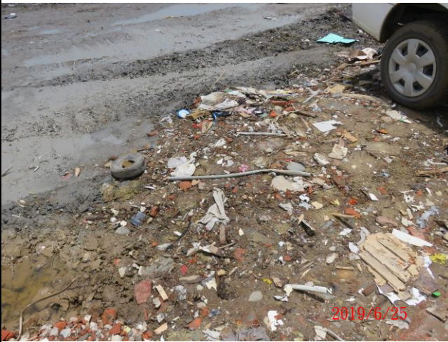
部分土方回填區回填材料摻雜磚塊、垃圾等雜物
