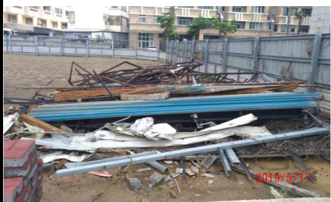
工地尚有拆除之鐵(鋼)板、H型鋼未清理
