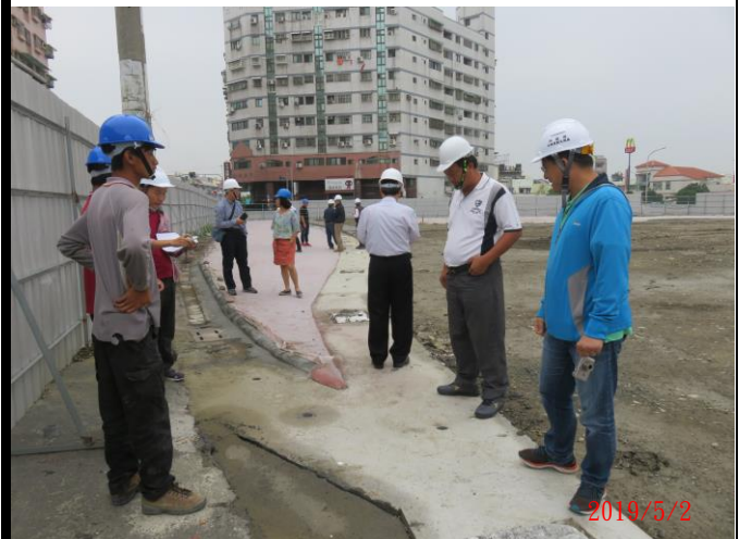
施工督導（工區現場）
