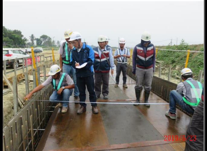
CA02 箱涵側牆模板表面未塗模板油，且模板老舊部分有破損或混凝土殘渣未清除乾淨
