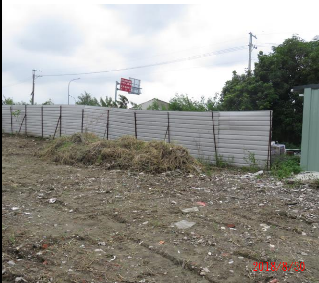
區內部分圍籬傾倒歪斜且未設置警示燈
