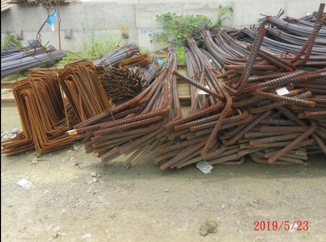
CB02 箱涵旁鋼筋直接置放於地面未墊高
