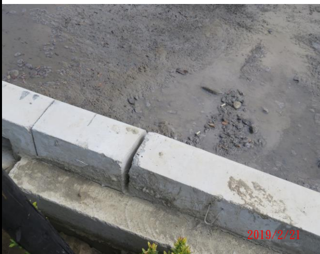
F 道路緣石有局部破損及縫隙過大情形
