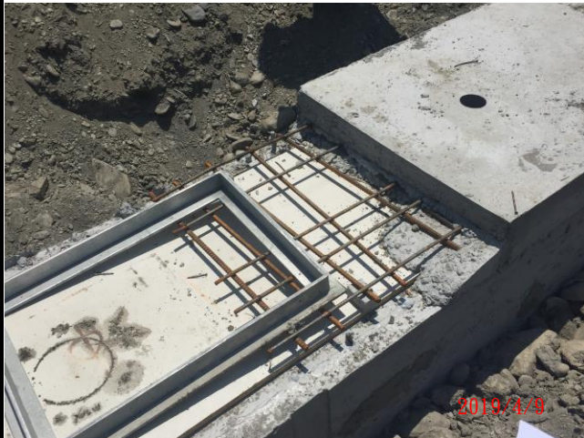
計畫道路側溝溝蓋版副筋綁紮間距控制不佳
