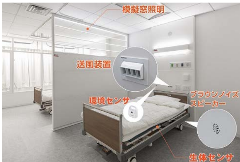
附圖 1.17 鹿島建設『醫院 NEM-愛茉莉(Nemamore)』技術，收集醫院中感測器的訊息連動空調、照明等設備
