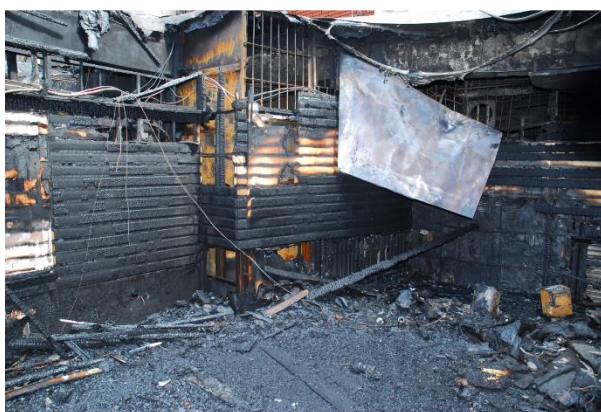
c.後側房間 全景現況
