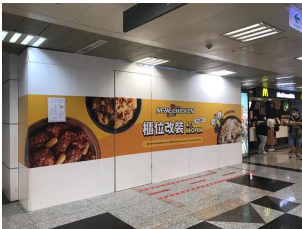
圖 3-16 施工區域與營業範圍間設置「實體區隔」作為屏障
