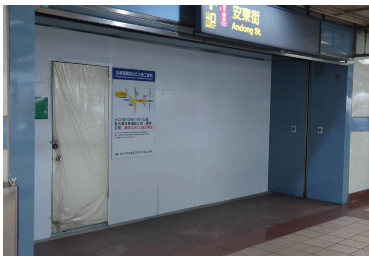
(b) 增築牆體後出入口設置防火門示意圖
