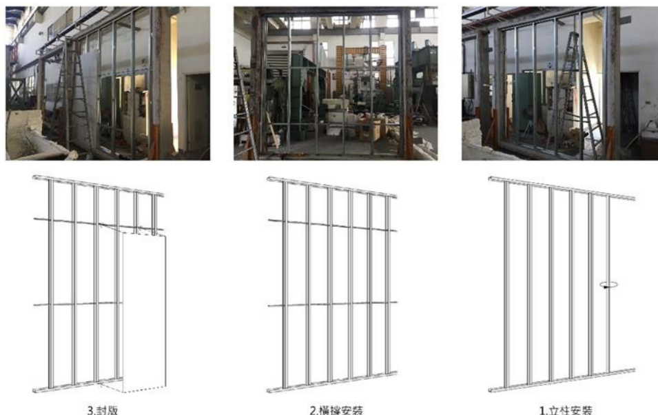
圖 3-4 簡易輕隔間牆工法試體組裝
