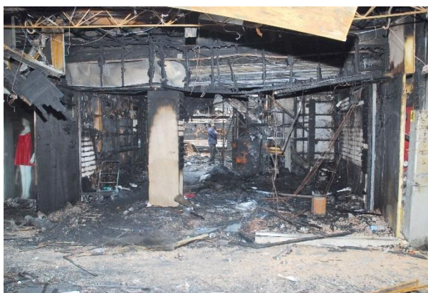
a.正面前廳 全景現況
