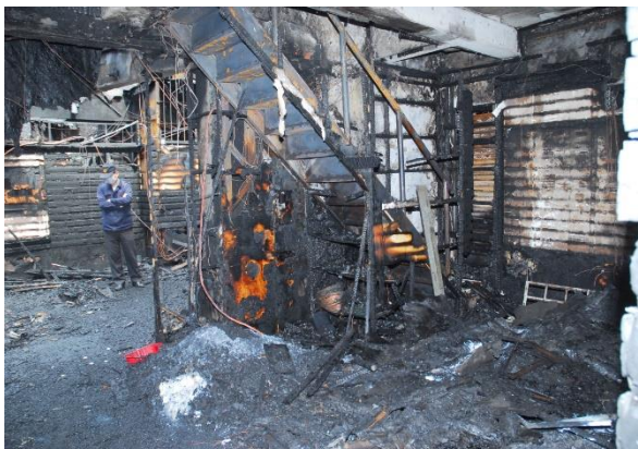
b.前廳樓梯 全景現況
