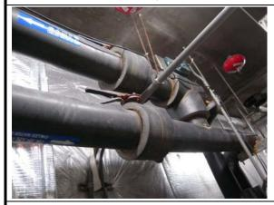
冰水系統三通閥老舊,無法正常作動,且 必須提供相同冰水流量至空調箱,導致冰 水泵耗能。
