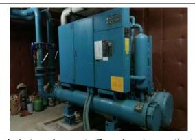
中央空調系統之超量設計、空調主機效 率老化,且經長時間使用造成效率下 降,皆是造成空調耗能之主因。
