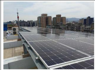
裝置太陽光電板搭配小型儲電系統, 串接市 電並用,另有屋頂隔熱效用。
