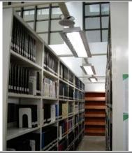
利用書櫃間之防傾倒鋼管,將燈具配置在 適當位置,並於走道設置紅外線感應器, 藉由光阻感應及透過人體感應,達到無人 時自動開關燈具,有效達到節能。
