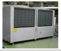
增設熱泵系統與現場鍋爐系統結合,熱 泵系統做為預熱或先發運轉,大幅提高 整體熱水系統能源效率。
