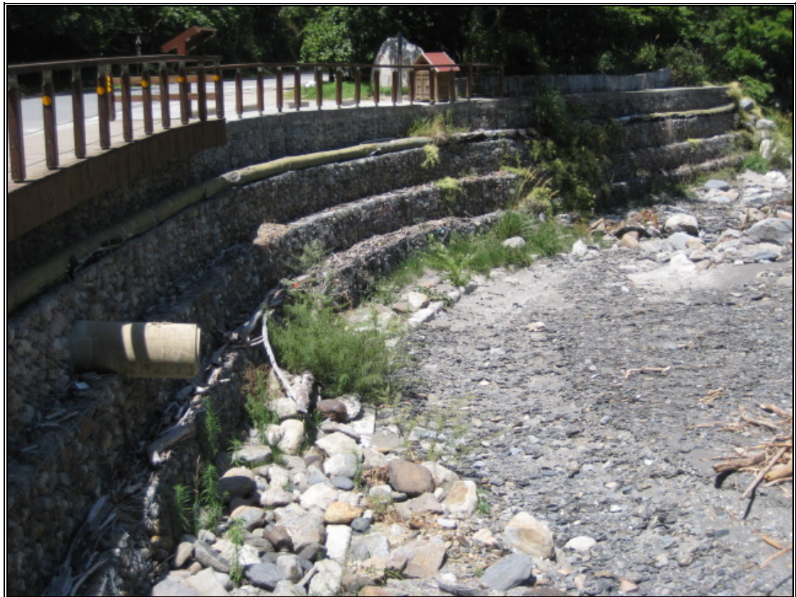
照片 4-1-15 七家灣溪部分蛇籠護岸情形(攝於 2009 年 9 月)
