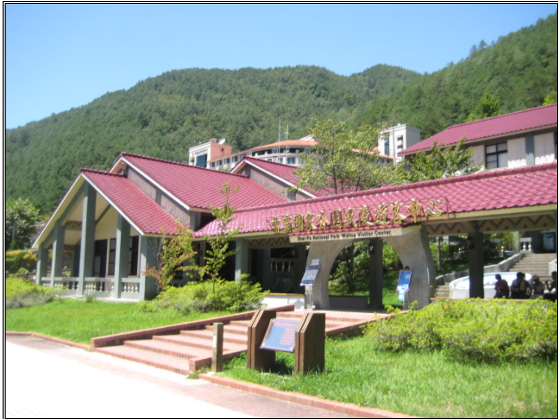
照片 4-1-10 雪霸國家公園武陵遊客中心一景( 攝於 2009 年 9 月 )
