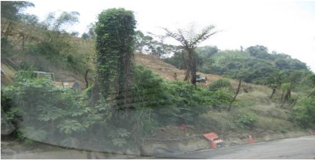
照片 3-1 道路邊坡崩塌情形( 攝於 2009 年 9 月 )
