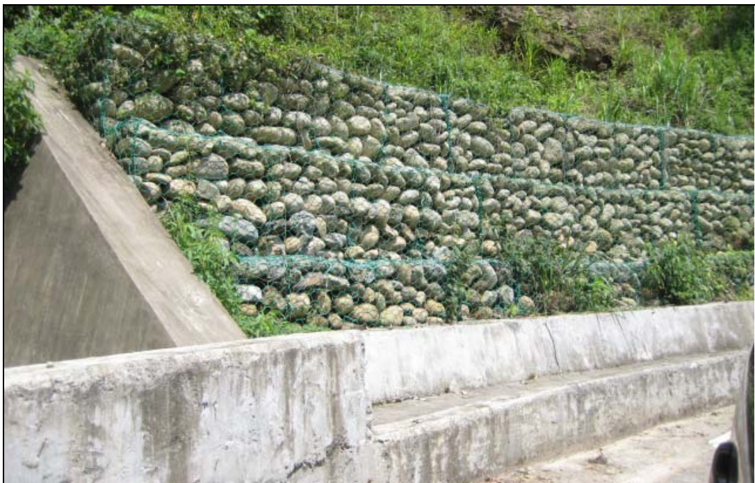
照片 4-1-1 司馬限林道道路上邊坡蛇籠護岸工程(攝於 2009 年 7 月)
