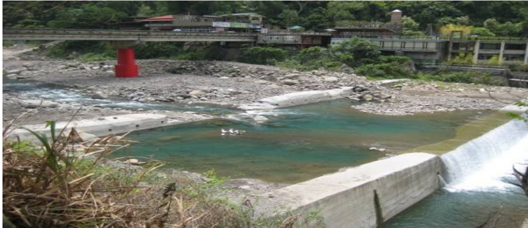
照片 2-1 調查中點(溫泉區之汶水橋)(攝於 2009 年 9 月)
