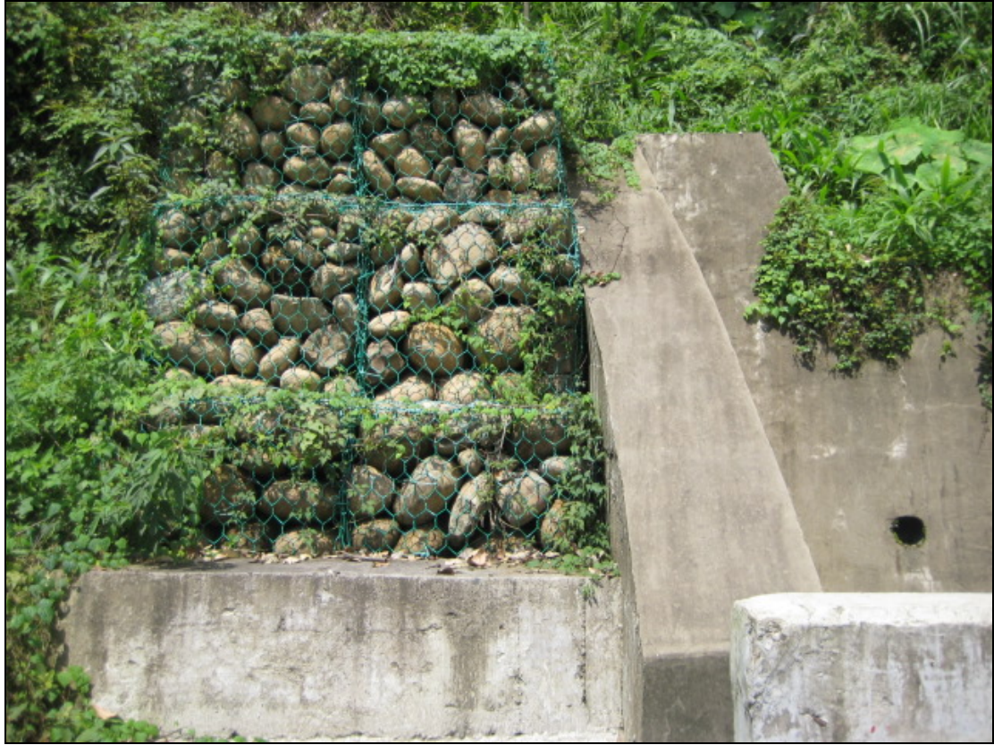
照片 4-1-2 司馬限林道道路上邊坡蛇籠護岸工程(攝於 2009 年 7 月)
