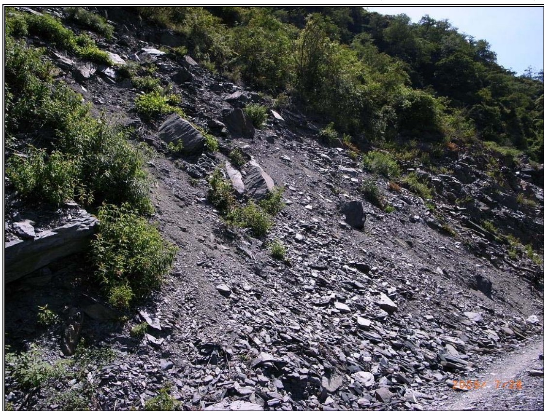
照片 4-1-8 大鹿林道東線道路邊坡崩塌情形之四( 攝於 2009 年 8 月 )
