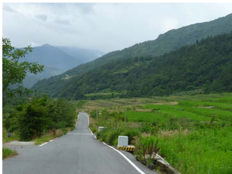
照片 20 武陵谷地的道路呈 現上下起伏的現象 是因經過七家灣溪 聯合沖積扇所致
