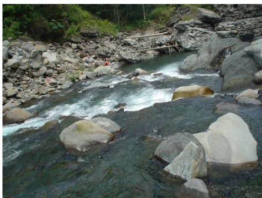
照片 2-24 二號石壩下游面(2009/06)
