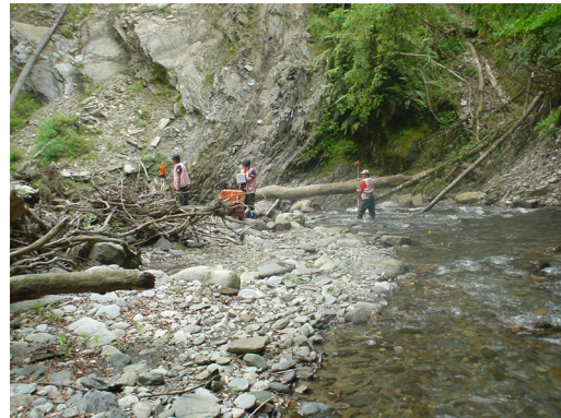
照片 2-10 断面 3-17 崩塌(2007/06)
