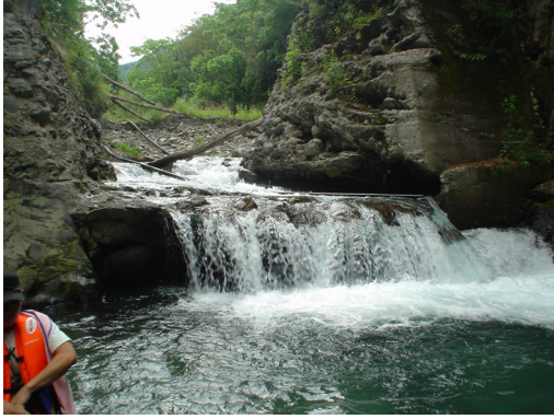
照片 2-18 二號壩口(2007/06)
