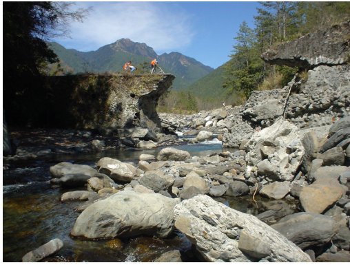
照片 2-34 二號石壩下游面(2007/02)
