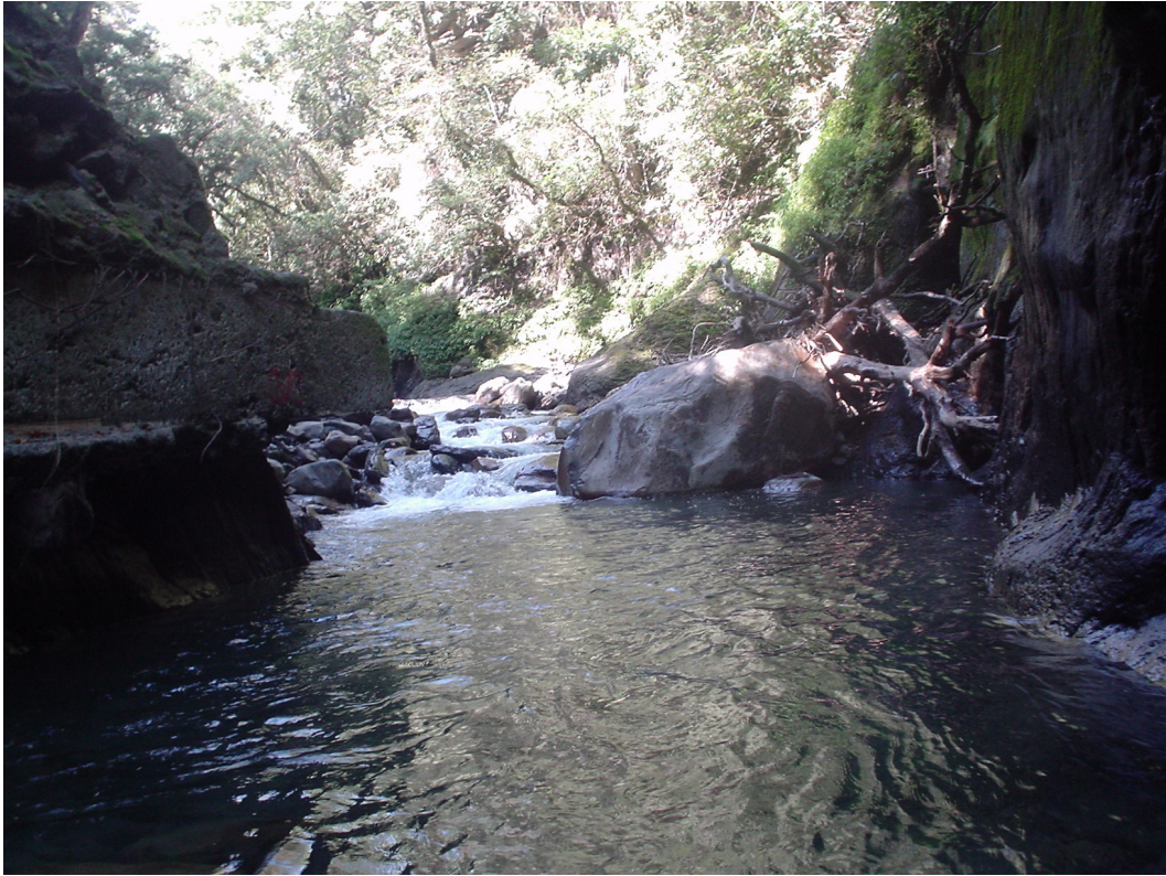
照片 2-13 三號壩壩口(2007/11)
