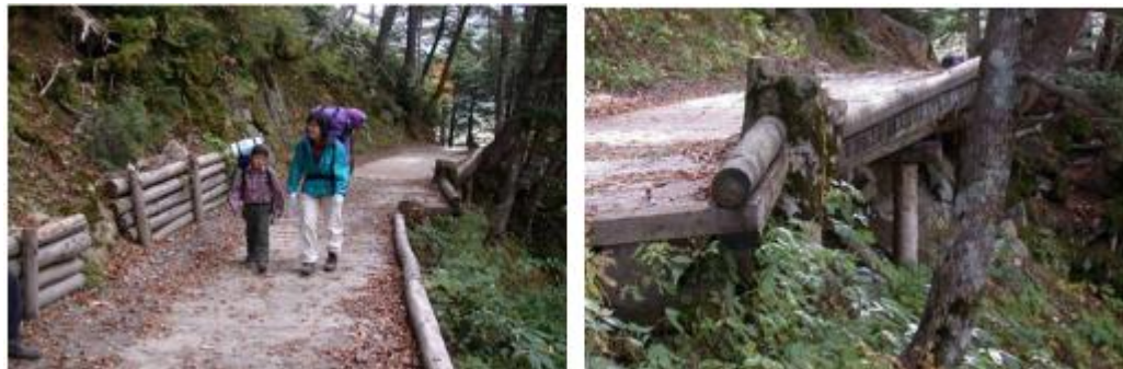
圖 e 中部山岳國立公園登山健行步道邊坡穩定簡易保護措施
