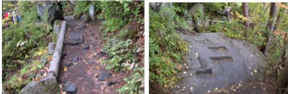
圖 a 磐梯朝日國立公園自然探勝步道施作工法
