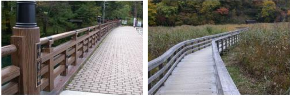
圖 b 日光國立公園中禪寺湖橋鋼構欄杆以木紋外包覆及沼澤區以木棧橋架設
