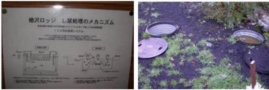
圖 d 中部山岳國立公園槍澤山莊廁所採生物式土壤處理循環 TSS 法
