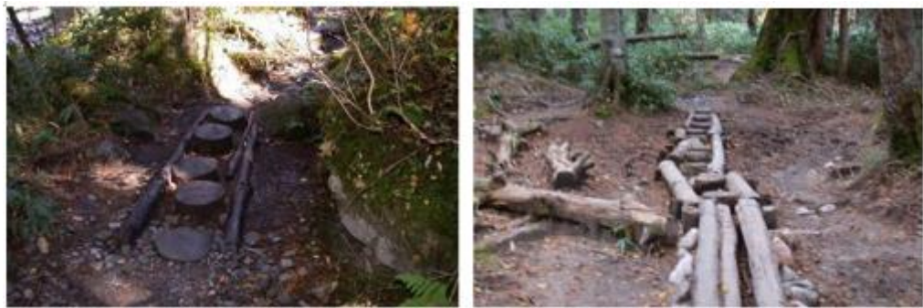
圖 a 中部山岳國立公園登山健行步道施作工法
