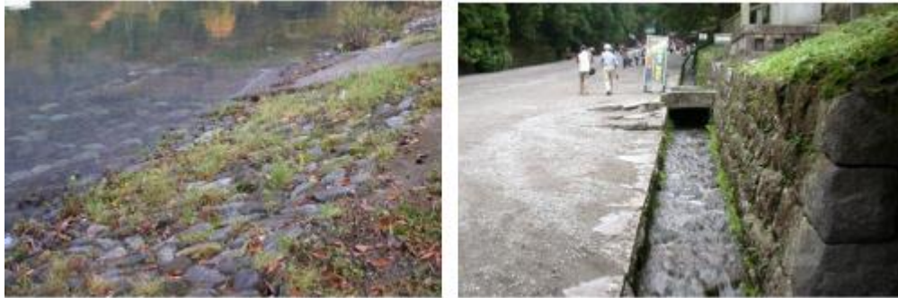
圖 a 日光國立公園中禪寺湖旁邊坡保護砌石及東照宮道路旁砌石式排水溝
