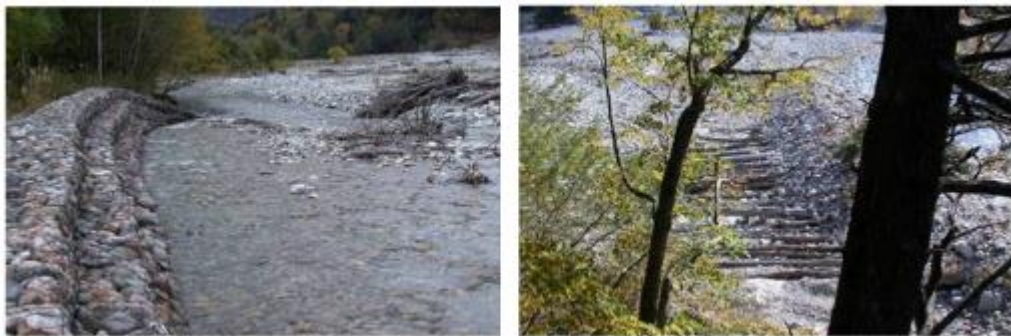
圖 c 中部山岳國立公園梓川防水流沖刷之蛇籠保護工法及漂流木河道應用
