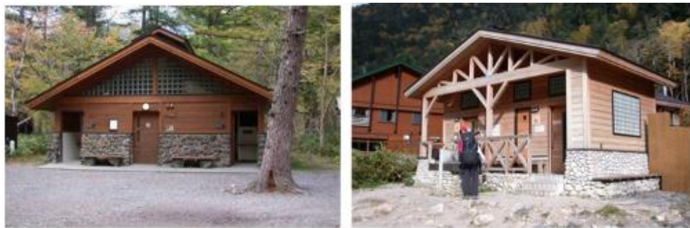
圖 c 中部山岳國立公園上高地及橫尾木構造建築廁所
