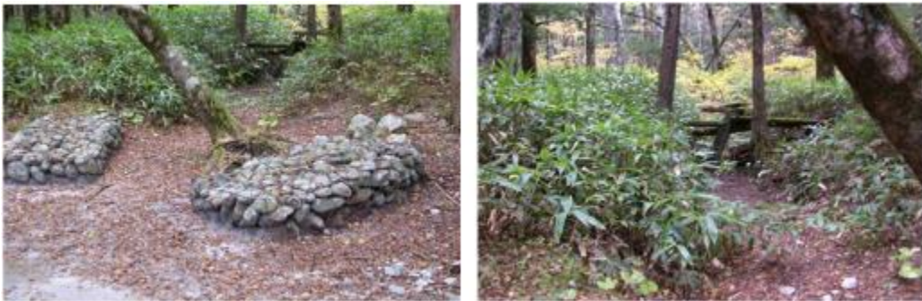
圖 b 中部山岳國立公園步道上邊坡防水流沖刷以堆石及倒木橫置保護
