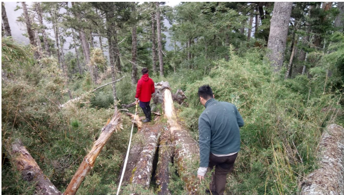
圖 17. 臺灣冷杉長期監測樣區修復工作照
