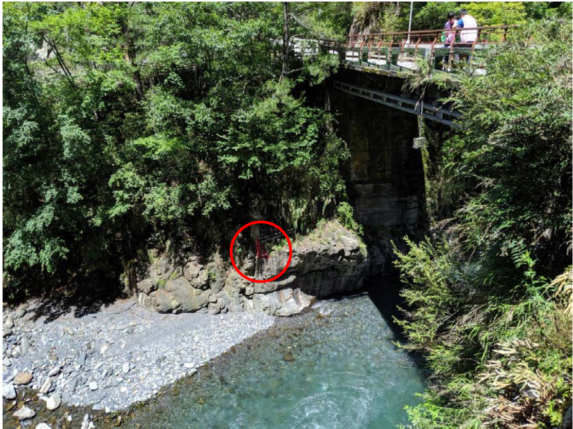
圖 5-6 萬壽橋之警戒水位線
