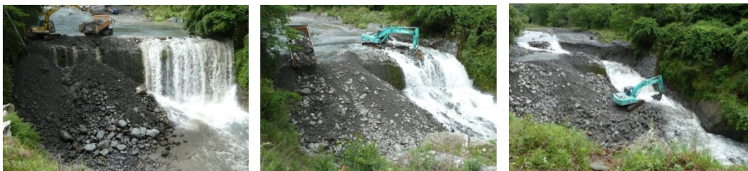
(A) 土砂回填 (B) 開始壩體改善工程 (C) 壩體工程改善完成
