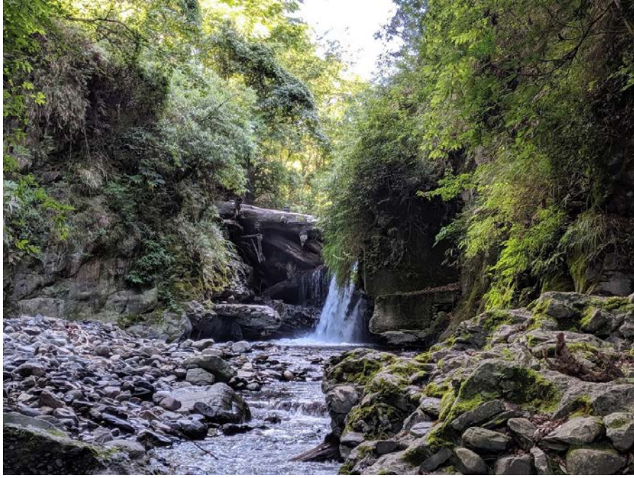
圖 5-26 高山溪二號壩現況
