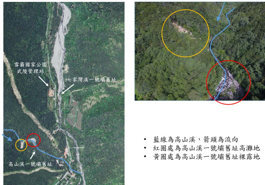
圖 5-25 高山溪一號壩上游裸露地
