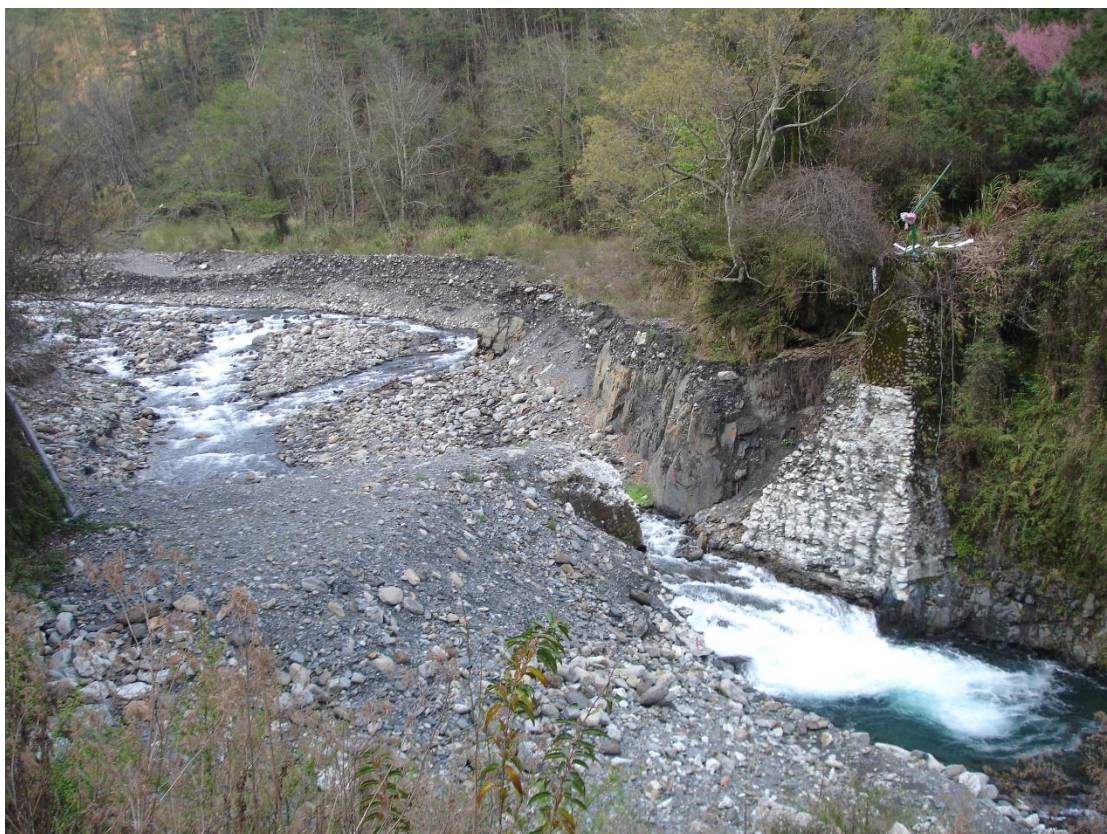
圖 1-6 2011 年五月底，雪霸國家公園管理處順利完成七家灣溪一號防砂壩拆除改善工程，開通溪流生物生態棲地廊道 (資料來源：本研究資料)
