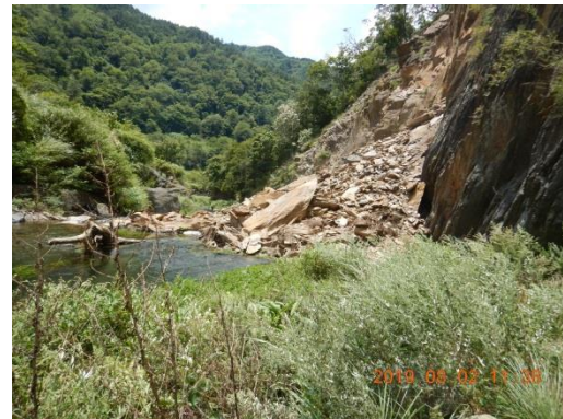
Y-66 斷面處右岸崩塌
