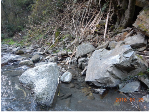
近護岸河岸崩塌，且護岸裂縫產生
