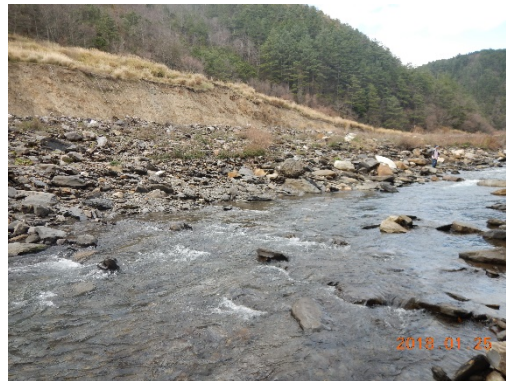
右岸土砂堆置處有滑落情形
