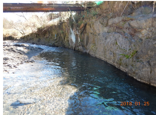
Y-29 斷面左岸為岩盤，右岸則有土砂堆積
