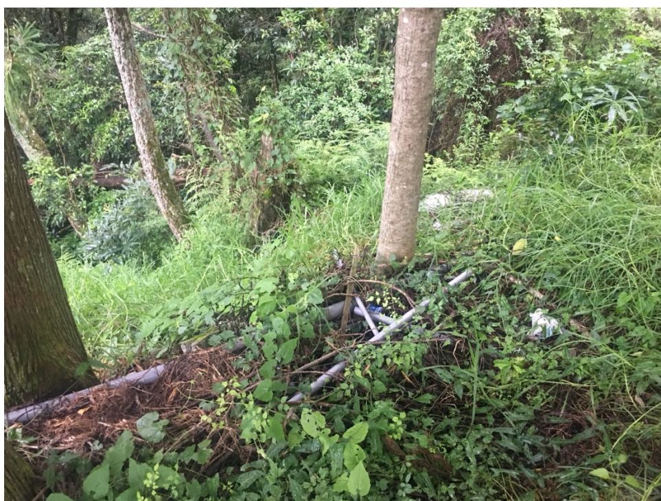
圖 4-81 武陵農場露營區污水處理設備面板旁之接管(無法判斷流向) (資料來源：本研究資料)
