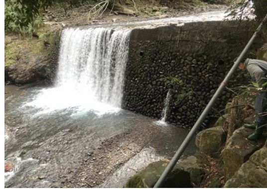
有勝溪一號壩下現況
