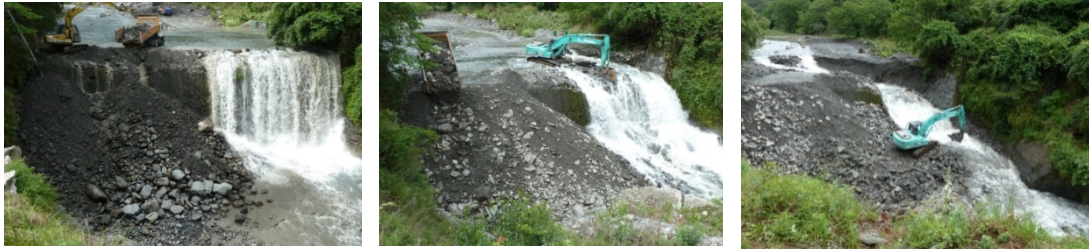
(A) 土砂回填 (B) 開始壩體改善工程 (C) 壩體工程改善完成
