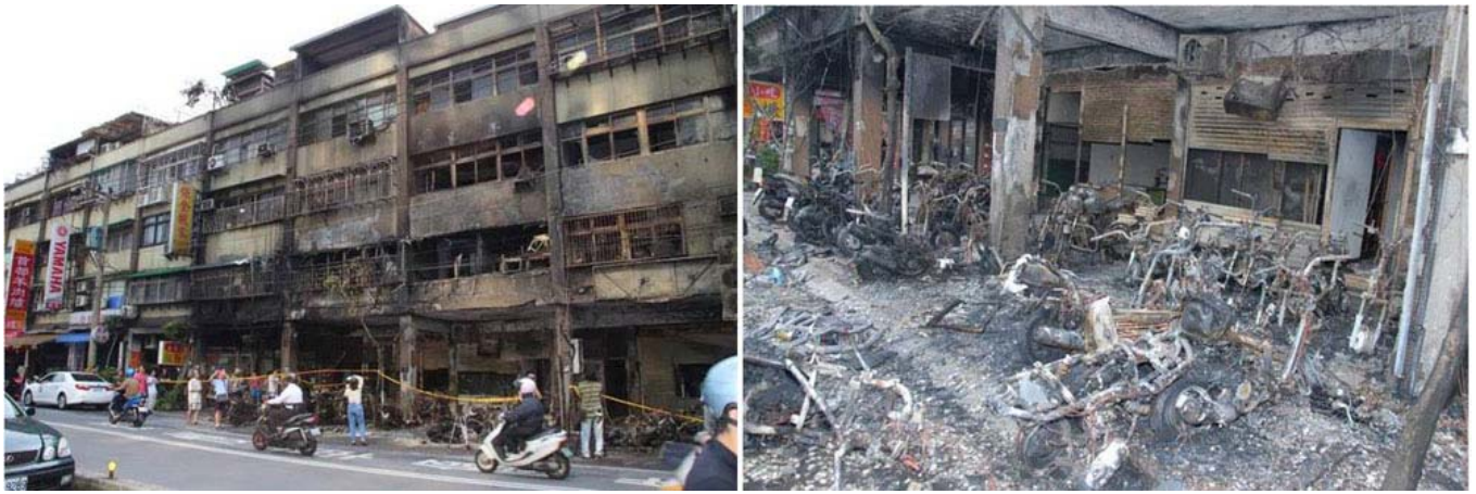
圖1. 新北市永和區成功路騎樓火災
