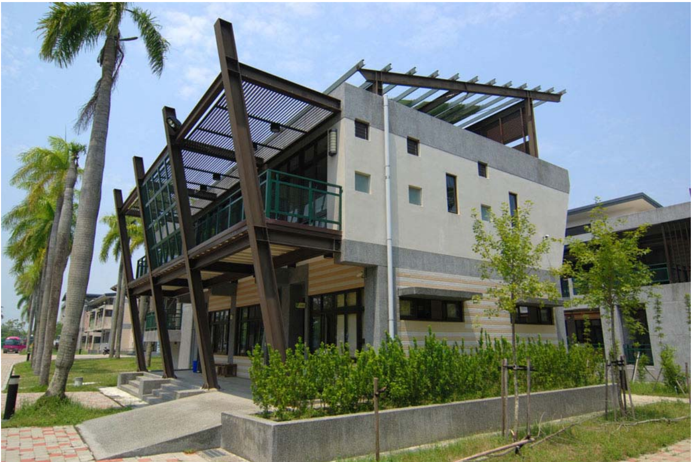
圖6 99年度後壁國中拆除重建工程
