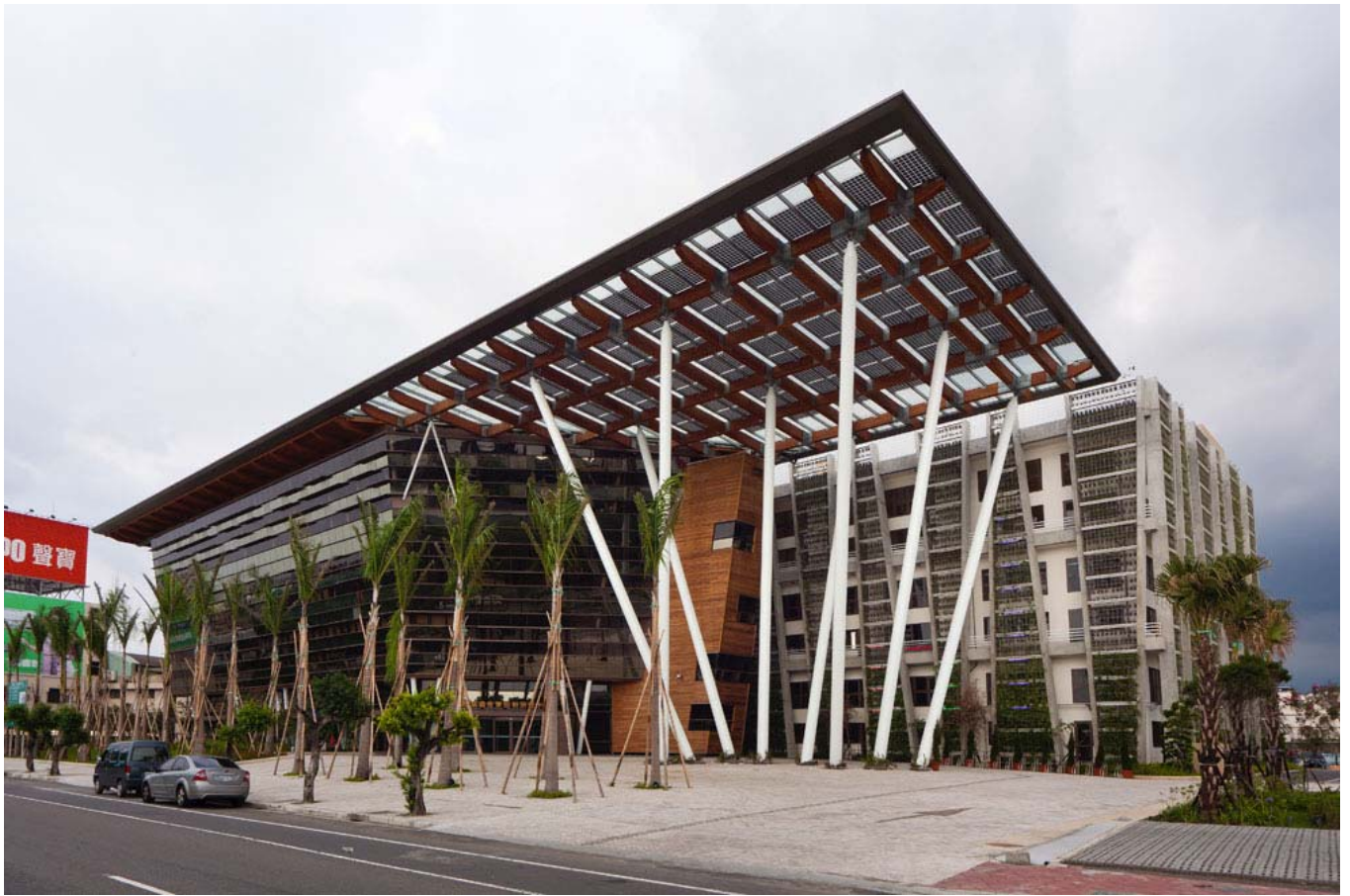
圖7 經濟部嘉義產業創新研發中心第一期新建工程
