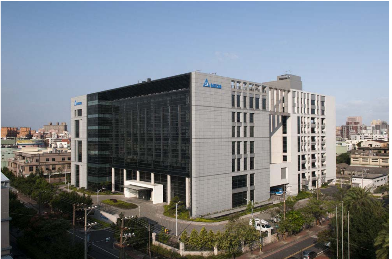
圖13 台達電子桃園三廠新建工程
