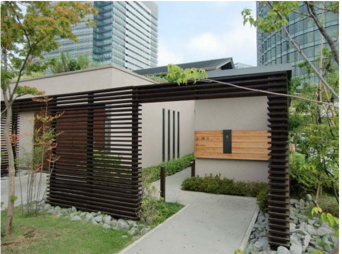
圖1 「觀環居」入口廊道及監視設備
