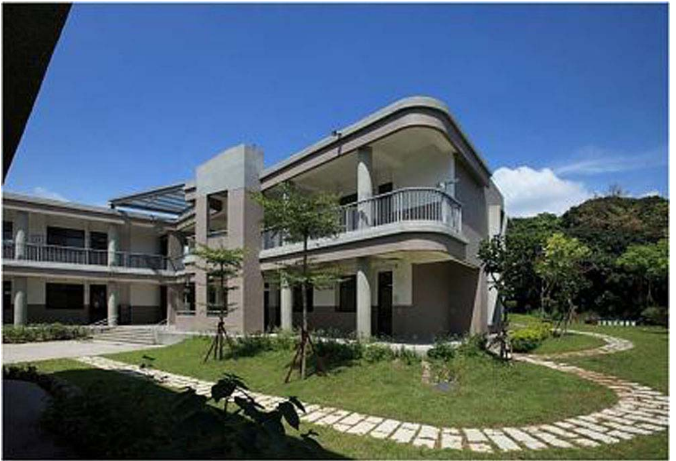
圖4 臺中市大坑國民小學整建工程
