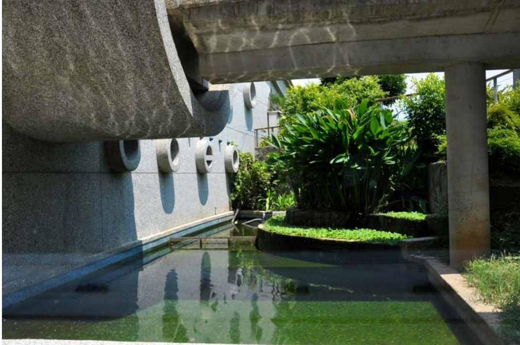
圖6 綠建築教育示範基地 – 淡海污水處理廠
