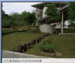
大片屋頂鋪設以利用雨水的收集
