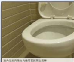
室內浴室與陽台均使用石質再生面磚
