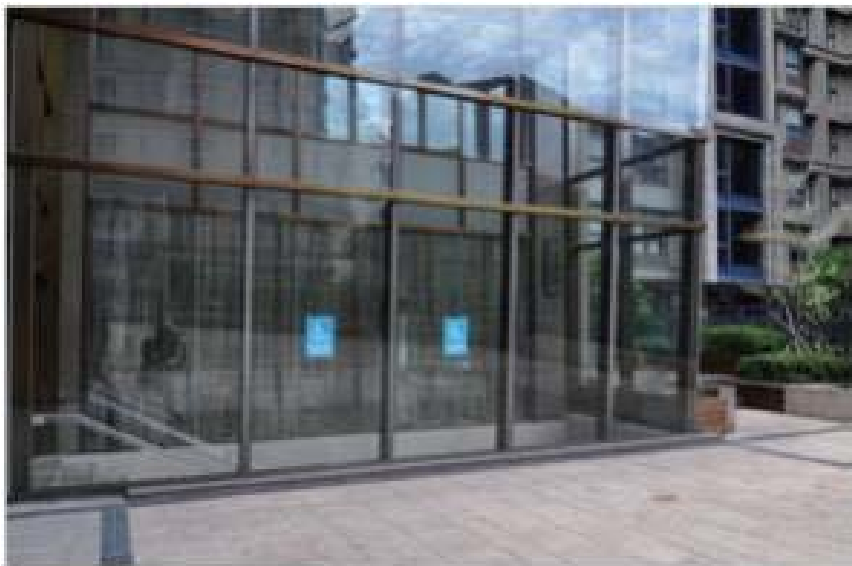
圖1 入口處清楚標示無障礙指示標誌
