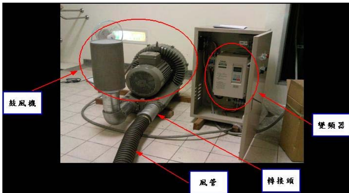
圖1、水平噴流防煙系統設備示意圖
