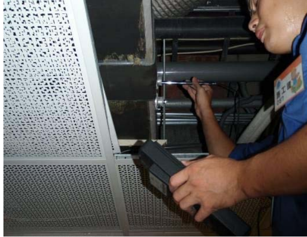
進行改善前之風速量測
