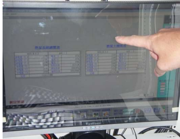
增設熱泵BEMS系統
