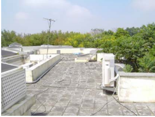
綠屋頂改善前
