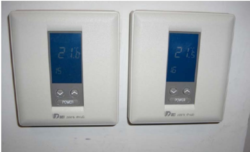
圖1 數位化之室內溫度控制器
