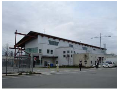
圖2 國家工程院區行政大樓
