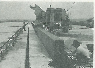
鋪築機施作情形
