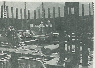
鋼殼沈箱施工情形
