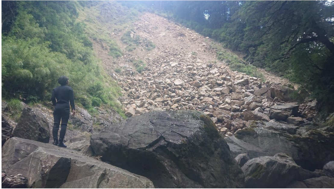
照片 3：合歡溪華岡水源地坍方處
