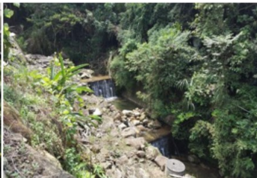
清泉橋上游野溪整治二期工程
