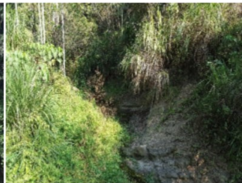
牛角坑土地公廟旁野溪整治工程
