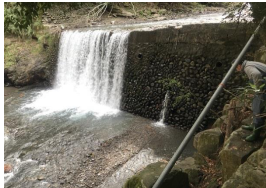
有勝溪一號壩下現況
