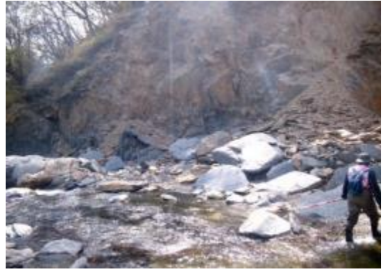
Y-66 斷面處右岸崩塌
