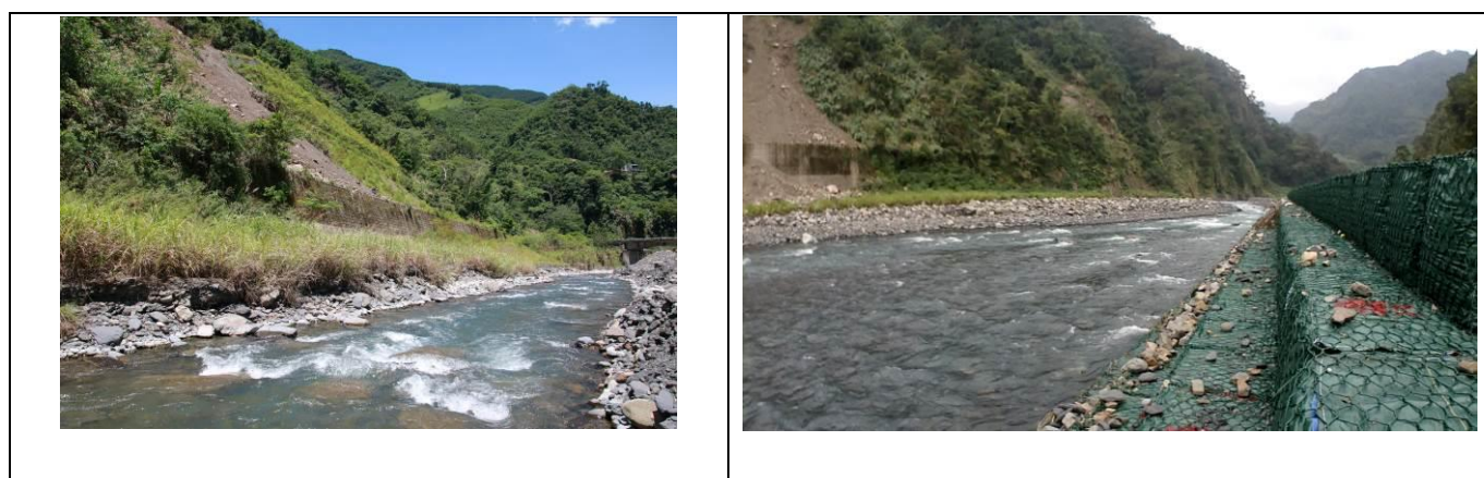
圖 6 樣區 B 之護岸工程
