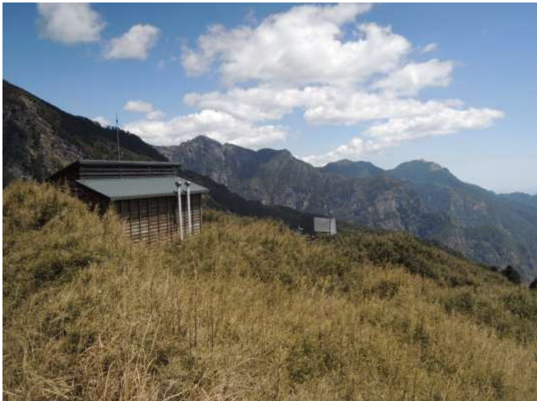
圖 13: 2016 年 4 月架設完成的 369 山莊氣象站與攔截網 (遠照)。
