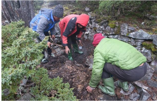
圖版 6- 120：翠池石屋 TP3 回填工作照 (2017.04.25)
