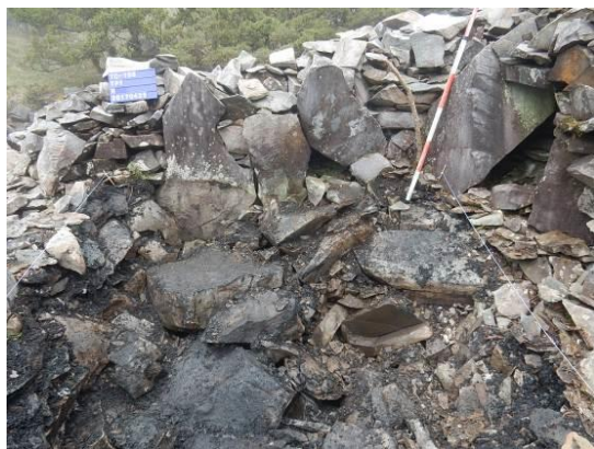
圖版 6- 88：翠池石屋 TP1-北側界牆斷面照（2017.04.25）
