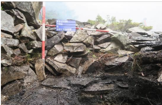
圖版 6- 112：翠池石屋 TP2-南側界牆斷面照 (2017.04.26)
