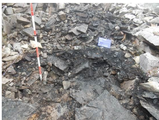
圖版 6- 90：翠池石屋 TP1-南側界牆斷面照（2017.04.25）
