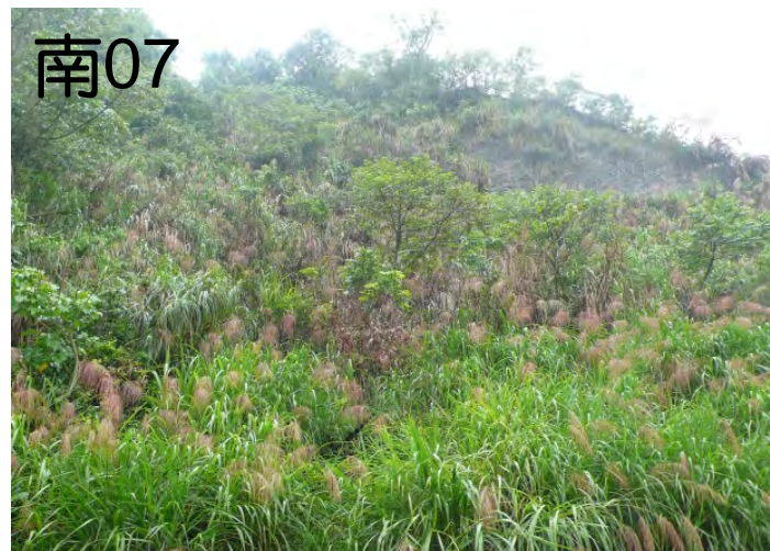
邊坡火燒後植被復原
