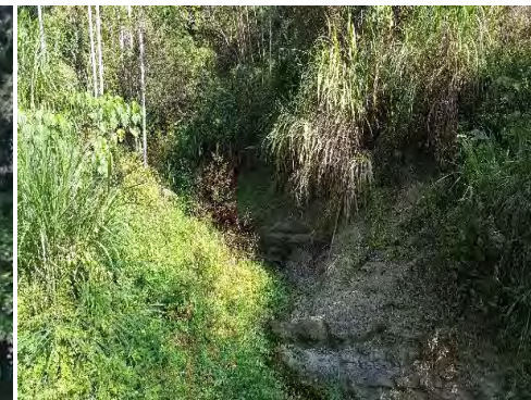
牛角坑土地公廟旁野溪整治工程
