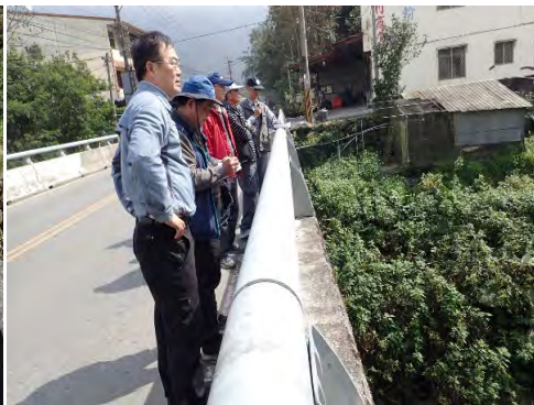
羅美橋上游野溪整治工程
