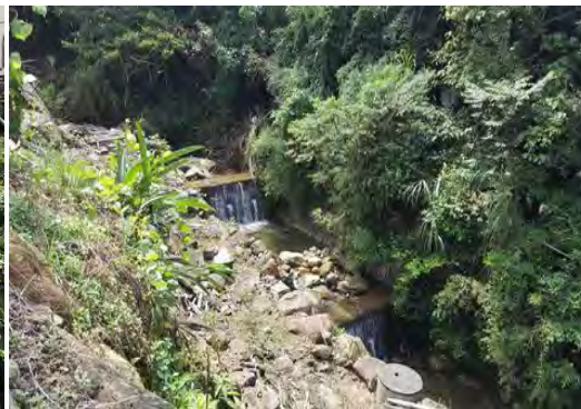
清泉橋上游野溪整治二期工程
