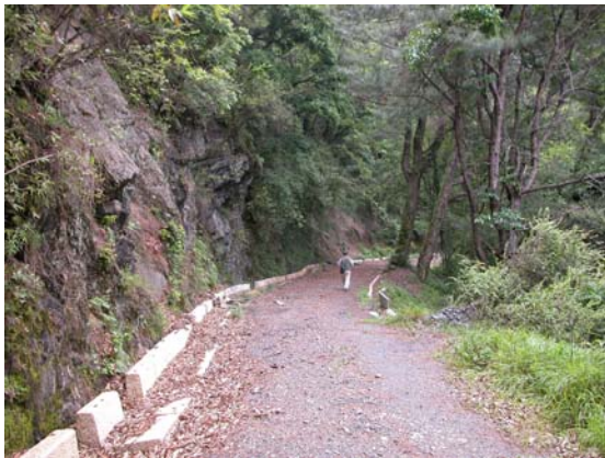
照片 3.105 未受損路段。
