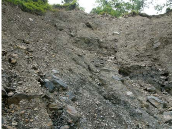
照片 4.28 上緩下陡地貌與近水平之黑色板岩露頭，和深厚之風化層，皆為長期崩塌之有利條件。
