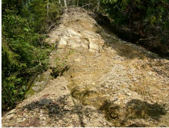
照片 4.11 人工上邊坡風化岩層滑落。
