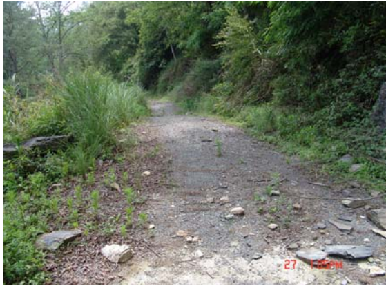
照片 3.53 未受損路段。
