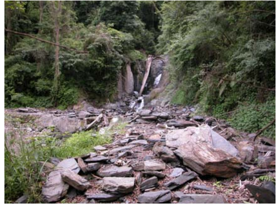
照片 3.115 溝谷口受損路段— 路面淤積。(4.2.18)
