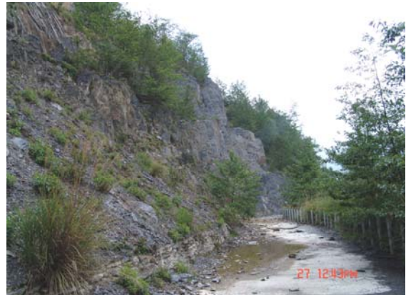
照片 3.56 上坡崩塌受損路段— 基岩崩塌。(3.1.11)
