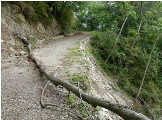
照片 3.68 未受損路段。
