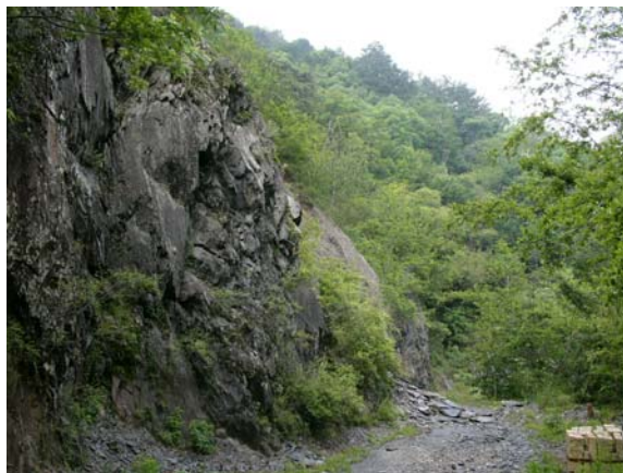
照片 5.5 中型峭壁，可掛網或以擋土牆加防落石柵。(道路 11K)
