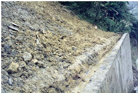
照片 5.16 以擋土牆阻擋土石和保護邊坡。
