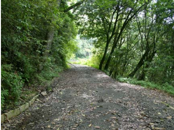
照片 3.42 未受損路段。
