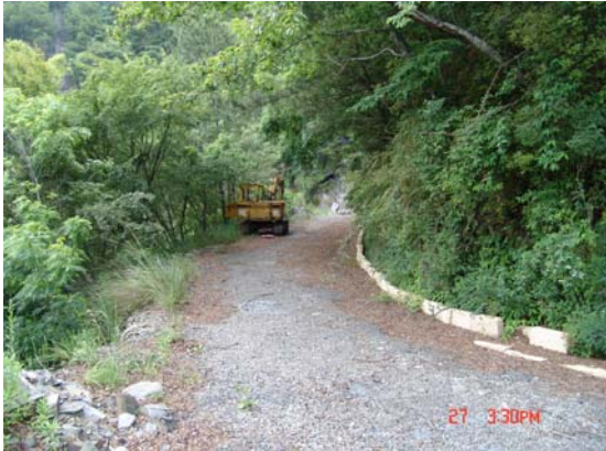
照片 3.76 未受損路段。
