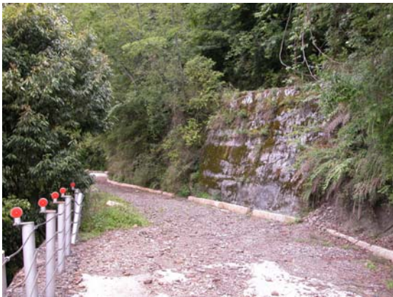
照片 3.110 未受損路段。
