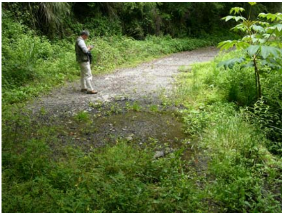
照片 3.49 未受損路段。
