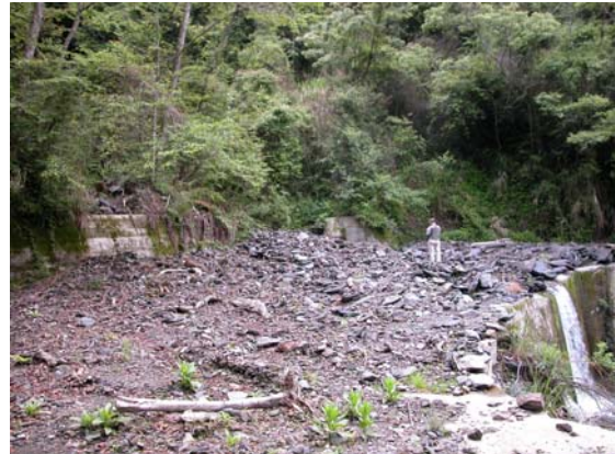
照片 3.95 溝谷口受損路段— 路面淤積。(4.2.12)
