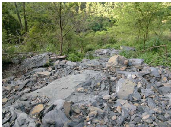
照片 4.8 自滑動體足部滾落至道路下邊坡之石塊，對坡面損害輕微。
