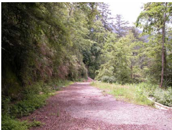
照片 3.123 未受損路段。
