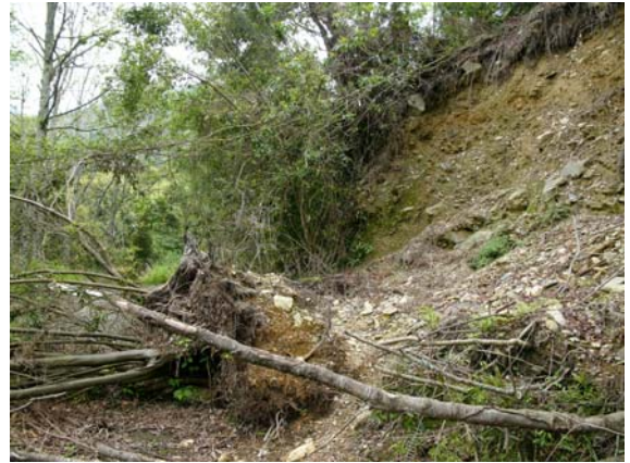
照片 3.29 上坡崩塌受損路段— 岩屑滑落。(3.3.2)。
