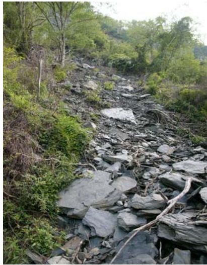
照片 4.6 新鮮板岩崩積層之再次崩塌埋沒和損壞路基。
