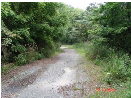
照片 3.51 未受損路段。
