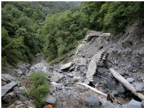
照片 4.32 山洪沖毀谷口道路及兩側路基。
