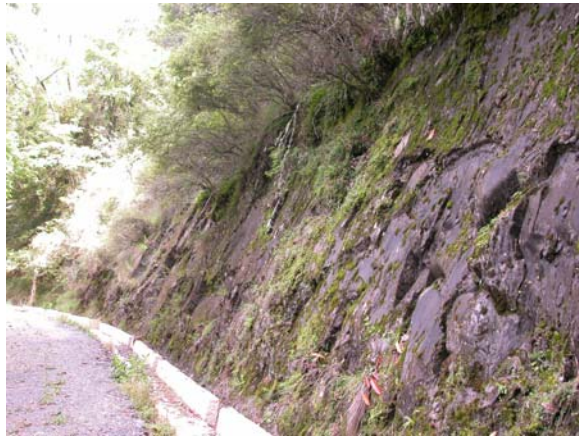
照片 5.6 穩定高之岩壁，可不予處理。(道路 15K)
