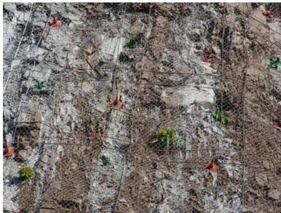
照片 5.4 峭壁掛網，以約束墜石於網中。
