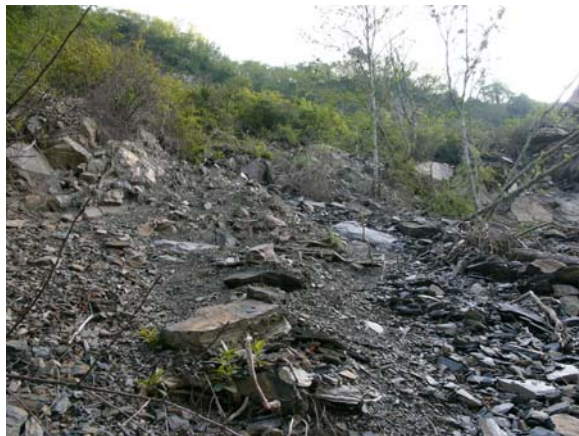
照片 5.10 逕流沖刷道路上邊坡土石，掩埋和損壞路面。
