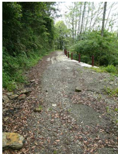
照片 5.18 路緣以混凝土構造物保護。
