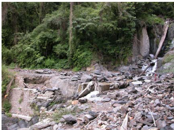
照片 4.35 道路橫過坑口，中斷其流路而造成沖淤。
