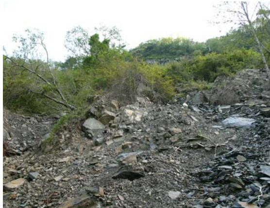
照片 4.9 道路上邊坡舊日滑動體受地表逕流沖刷成蝕溝，以及蝕溝側樹幹傾倒情況。
