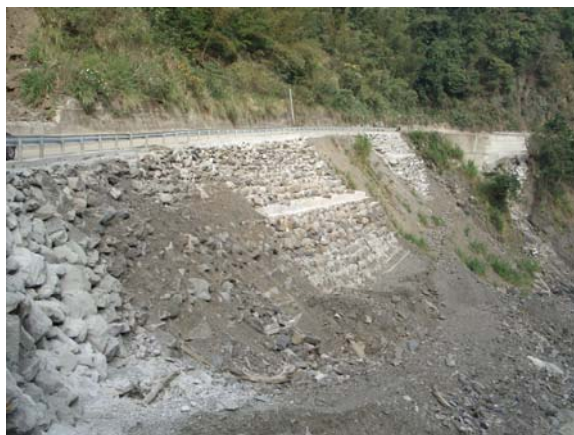
照片 5.41 建築穩固駁坎，以承受填方路基。
