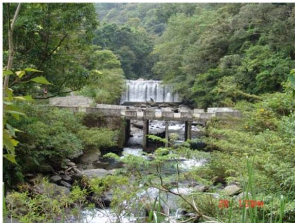
照片 5.36 跨越山谷之排水設施須有排除山洪之規模。
