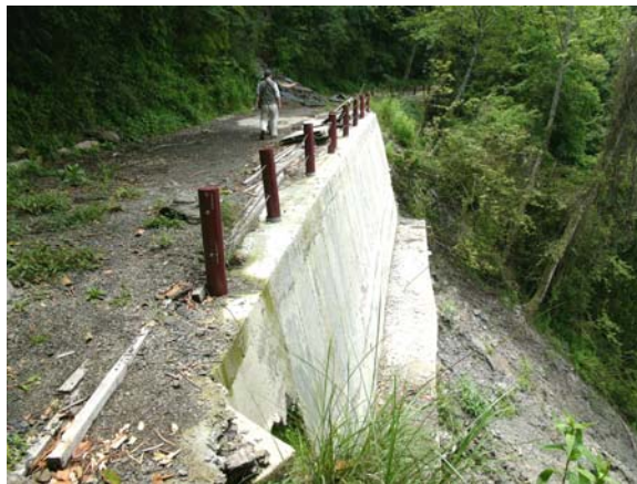
照片 4.22 路緣之混凝土護坡有阻止路緣沖刷之功能。
