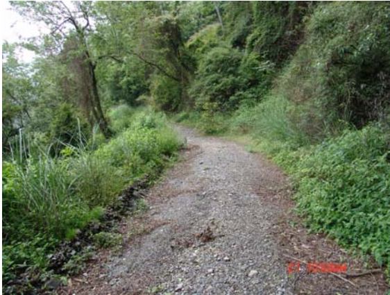
照片 3.34 未受損路段。
