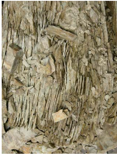
照片 4.2 道路上邊坡垂直板岩劈理造成有利邊坡崩落之環境。
