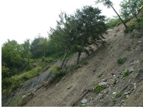
照片 5.30 山腹殘留滑動體穩定度低。
