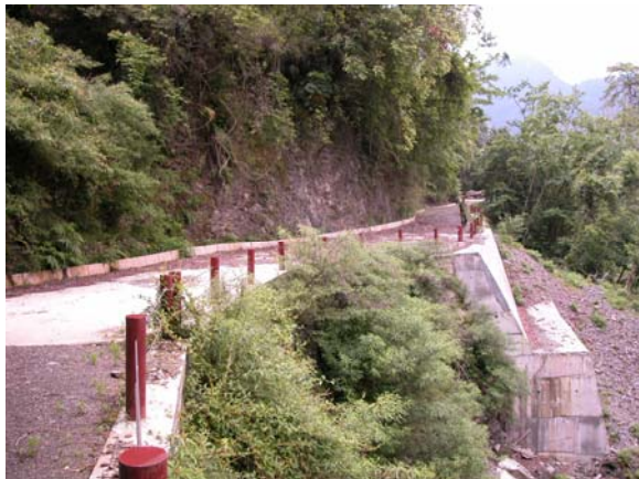
照片 5.23 以複式駁坎重建路基。
