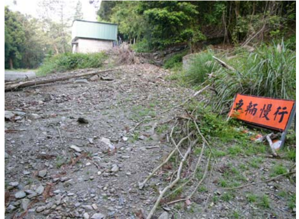
照片 2.9 土石漫流受損路段。
