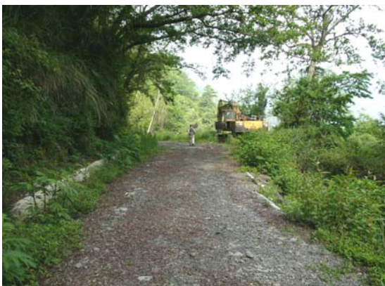
照片 3.74 未受損路段。
