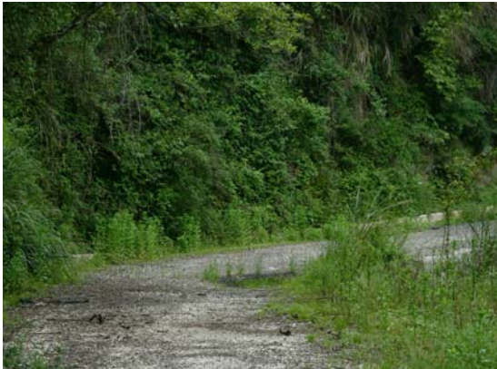
照片 3.70 未受損路段。
