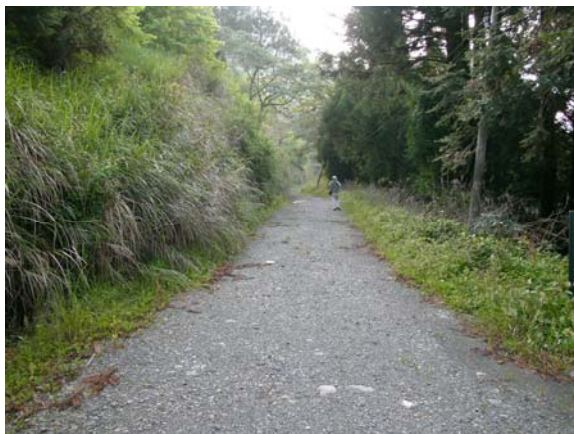
照片 2.1 未受損路段。
