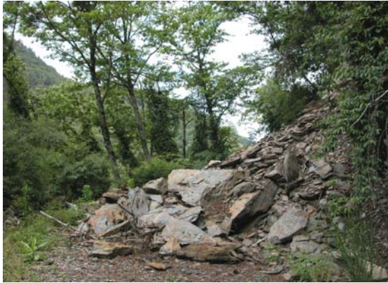
照片 3.131 上坡崩塌受損路段— 基岩崩塌。(3.1.34)
