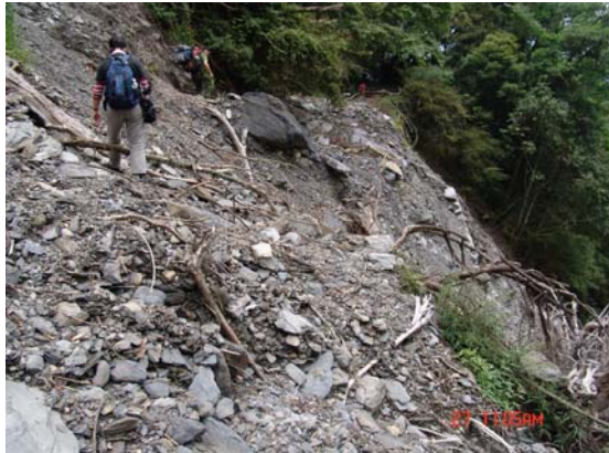
照片 3.82 路面受損路段— 路基崩失。(2.4.5)
