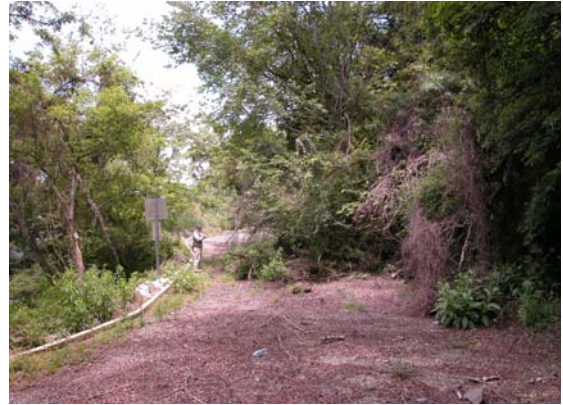
照片 3.126 上坡崩塌受損路段— 基岩崩塌。(3.1.31)
