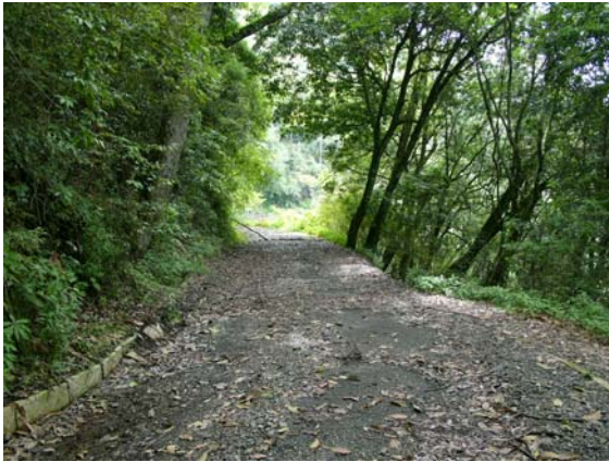
照片 3.37 未受損路段。
