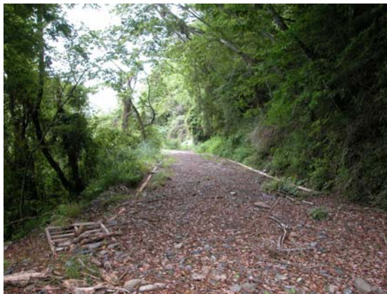
照片 3.116 未受損路段。
