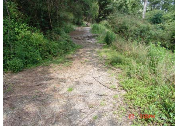
照片 3.71 路面受損路段— 路面龜裂。(2.1.6)
