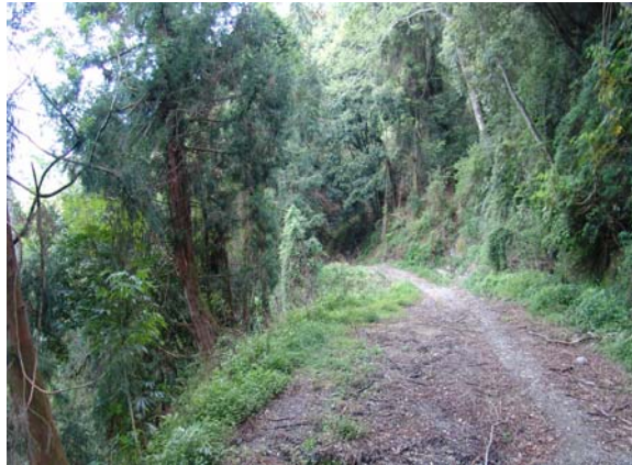
照片 4.49 填土方區道路下邊坡樹幹彎曲情況，顯示土壤之蠕移現象。
