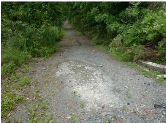
照片 3.57 未受損路段。
