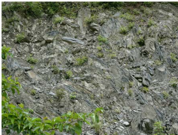
照片 4.13 人工陡上坡風化鬆動板岩。
