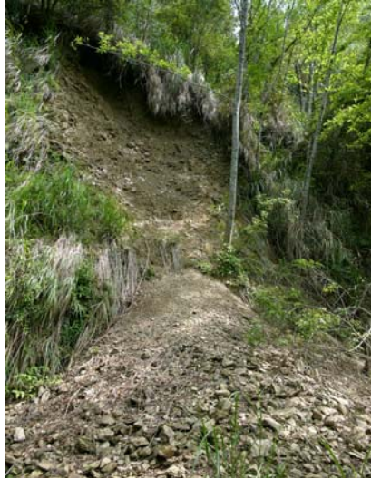
照片 3.18 上坡崩塌受損路段— 風化基岩崩塌。(3.1.2)
