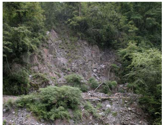
照片 3.113 上坡崩塌受損路段— 基岩崩塌。(3.1.24)
