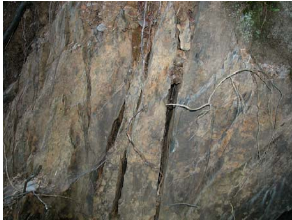
照片 4.4 垂直板岩節理有利雨水入滲，使水壓增加而崩塌。
