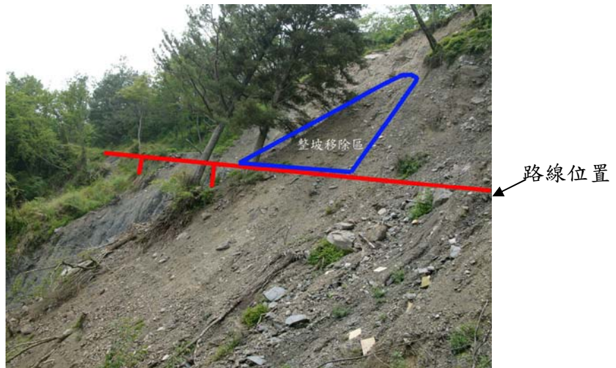
照片 5.32 將上邊坡不穩定滑動體清除，為修復路段方法之一。
