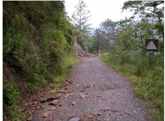
照片 3.90 上坡崩塌受損路段— 基岩崩塌。(3.1.16)
