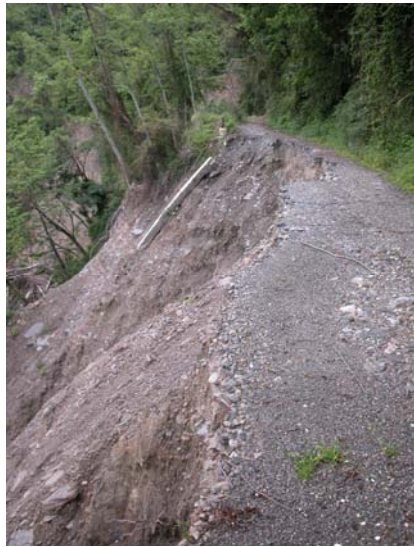
照片 4.20 全線幾無內側與橫向排水設施，以安全排除路面逕流。
