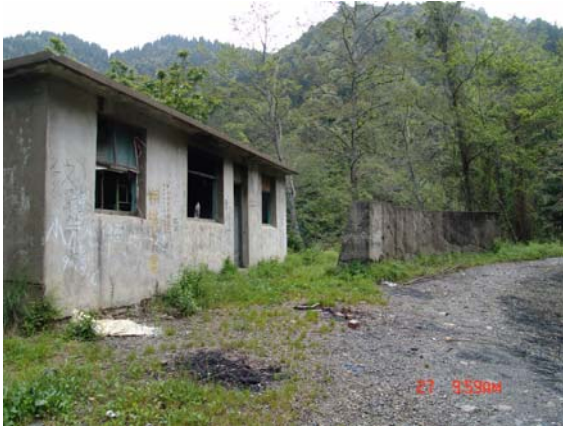
照片 3.28 未受損路段。
