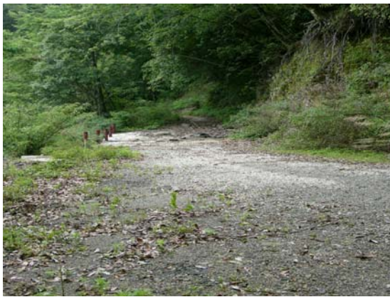
照片 3.61 未受損路段。
