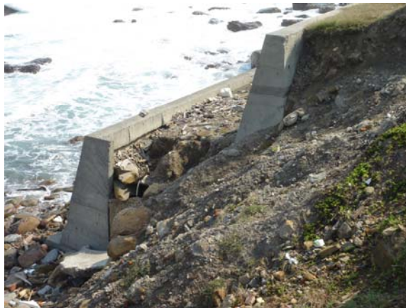
照片 5.39 路基外側設置擋土設施以穩定之。
