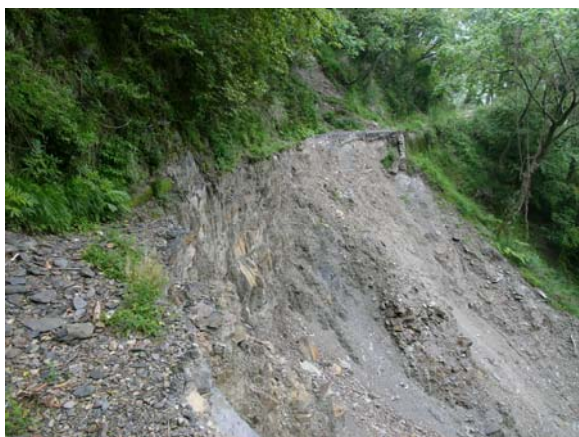
照片 5.22 路基被路面逕流沖蝕而崩失。
