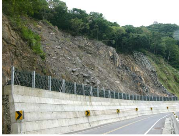
照片 5.9 擋土牆加防落石柵，以防止落石掉落路面。
