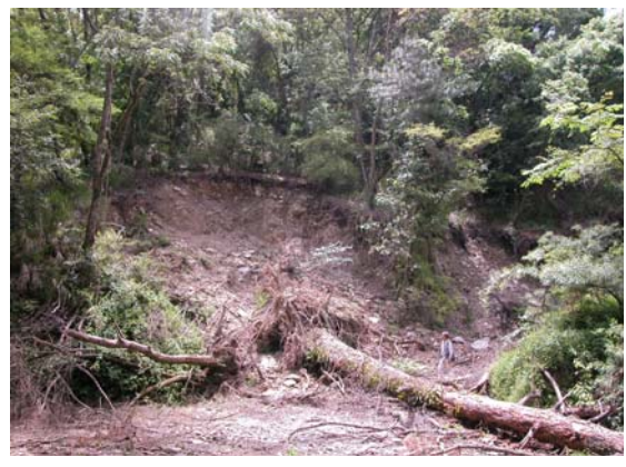
照片 3.124 上坡崩塌受損路段— 基岩崩塌。(3.1.29)
