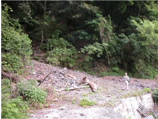
照片 3.103 溝谷口受損路段— 路面淤積。(4.2.16)
