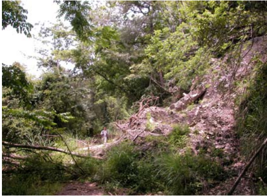
照片 3.125 上坡崩塌受損路段— 基岩崩塌。(3.1.30)
