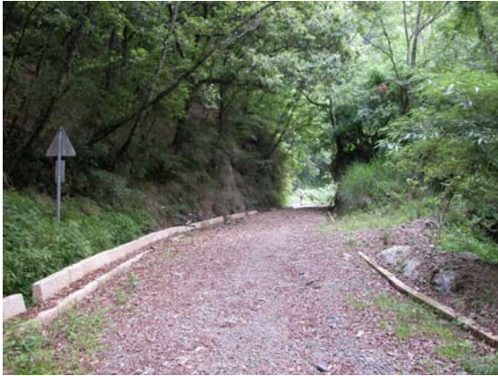
照片 3.108 未受損路段。
