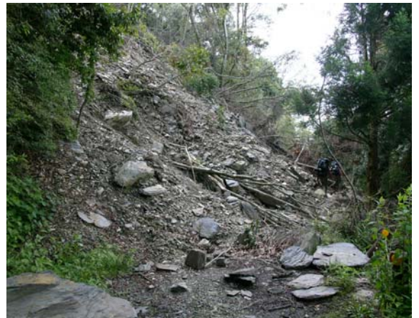
照片 3.15 上坡崩塌受損路段— 基岩崩塌。(3.1.1)
