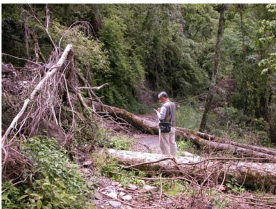
照片 3.112 上坡崩塌受損路段— 基岩崩塌。(3.1.23)
