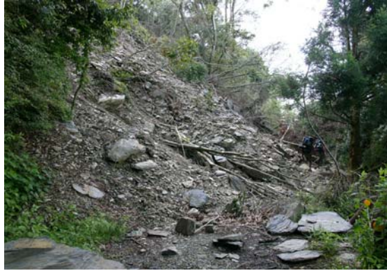
照片 4.14 風化岩層人工陡上坡引起土石滑落路面。
