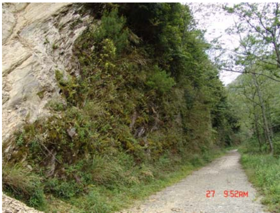
照片 3.24 未受損路段。
