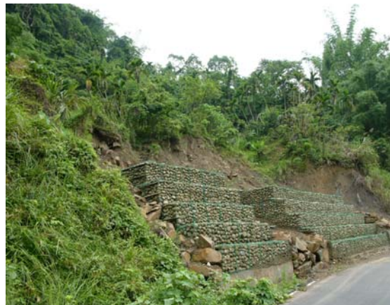
照片 5.12 以箱型蛇籠護坡。
