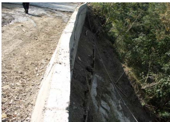
照片 5.21 以深入老土之駁坎重建路基。
