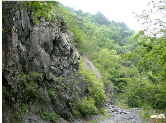
照片 4.3 道路人工上邊坡形成垂直節理面下坡之崩落自由面，造成有利岩壁之崩落之環境。
