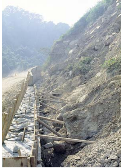
照片 5.11 興建擋土牆以防止邊坡移動。
