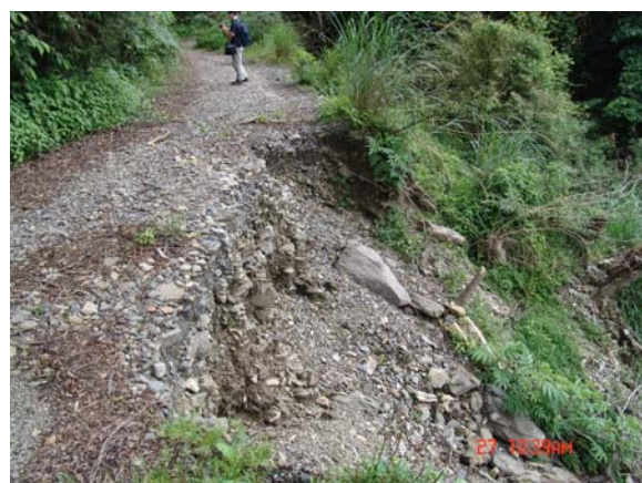
照片 2.3 路緣崩落受損路段。
