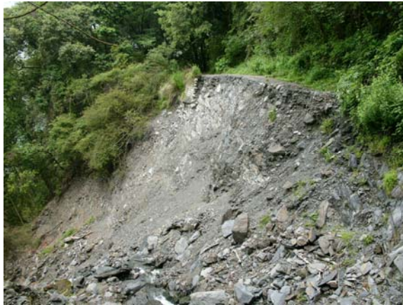
照片 4.24 板岩基岩面常為滑動面，乃因滲水沿基岩面流動所致。
