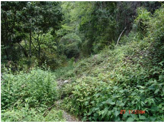
照片 3.44 上坡崩塌受損路段一 基岩崩塌。(3.1.9)
