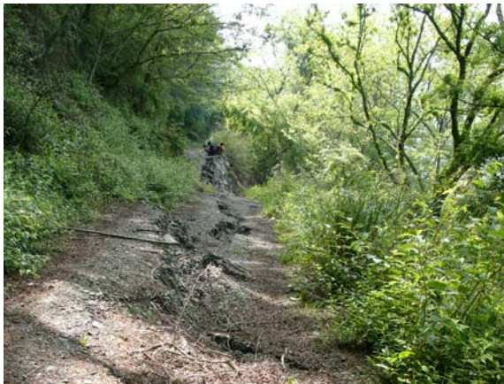
照片 3.14 路面受損路段— 路面塌陷。(2.3.5)
