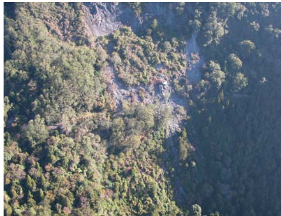
照片 4.7 損壞路段之航照，可見滑動體至道路為止，下坡影響不大。又峭壁滑動面已有植生，故可知滑動體非生於近期。
