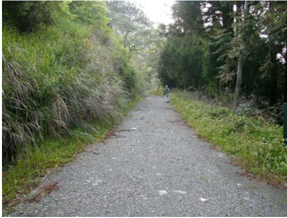
照片 3.1 未受損路段。
