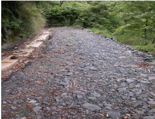
照片 3.94 未受損路段。
