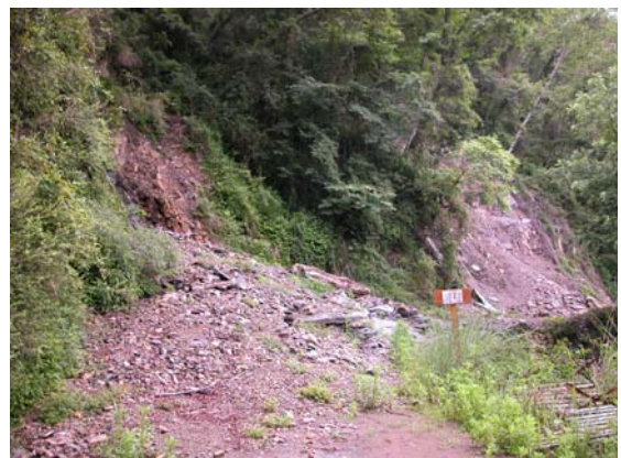
照片 3.92 溝谷口受損路段— 路面淤積。(4.2.11)
