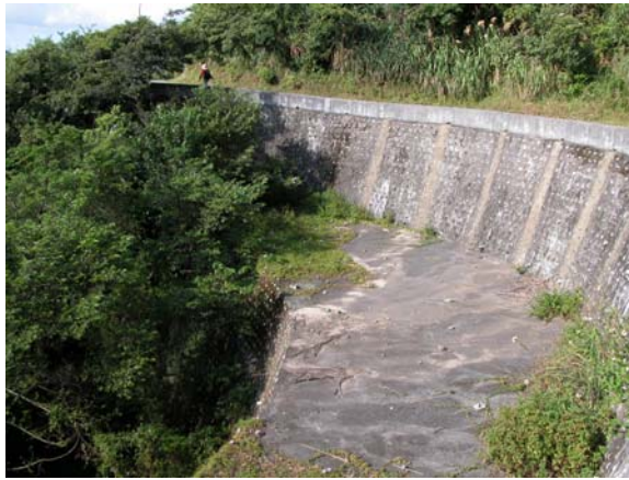
照片 5.24 以複式駁坎重建路基。
