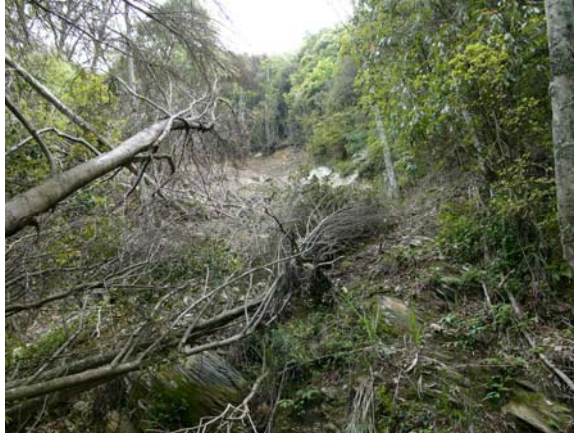
照片 5.14 岩屑滑崩，滑動體衝至路面。(道路 2K+200)
