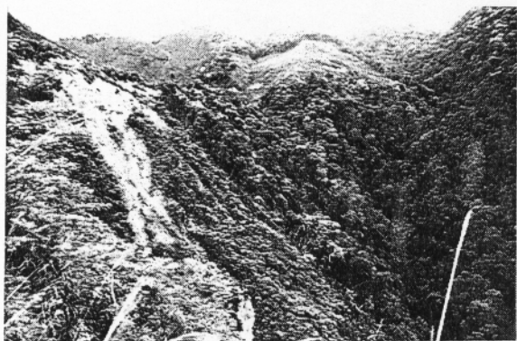
照片12.北坑溪古道在曙光整個路基崩塌，屬「再小心也很危險」的一級危險路段。
