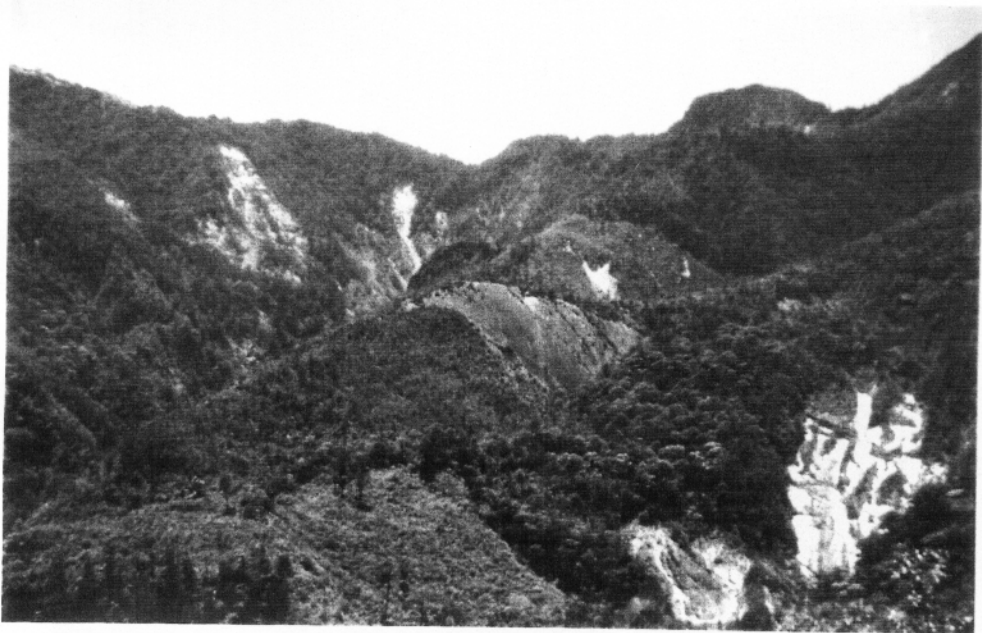
照片十四、X區之崩塌地問題區，產生大量土砂，故其下游建有三座防沙壩。
