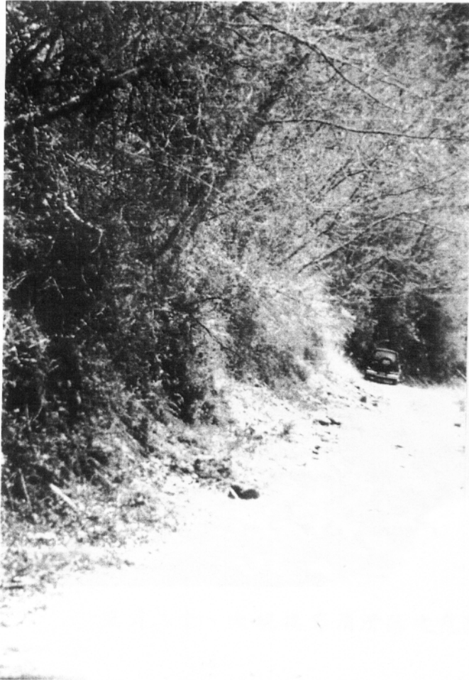
照片十八、林道通過陡坡敏感區，由高處崩石塊威脅行旅安全且難以防範。
