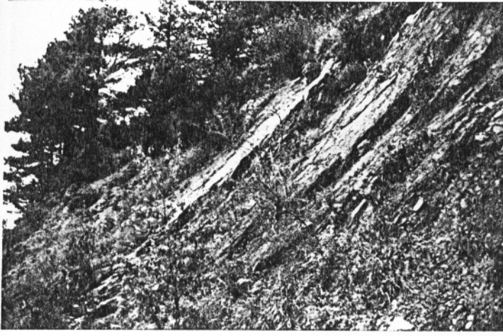
↑照片 2-1 輕度變質之泥質粉砂岩 高傾角順坡，其崩塌類 型為「岩石滑移」。
