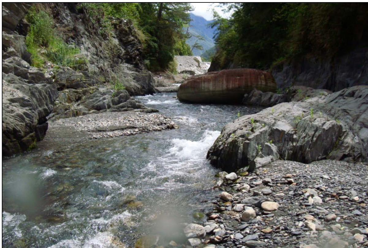
照片 1-2、七家灣溪一號壩下游樣站壩體改善後之環境照
