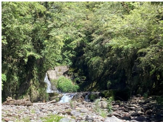
0K+125 四號副壩
