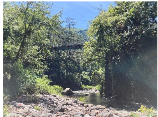
0K+000 吊橋下方
