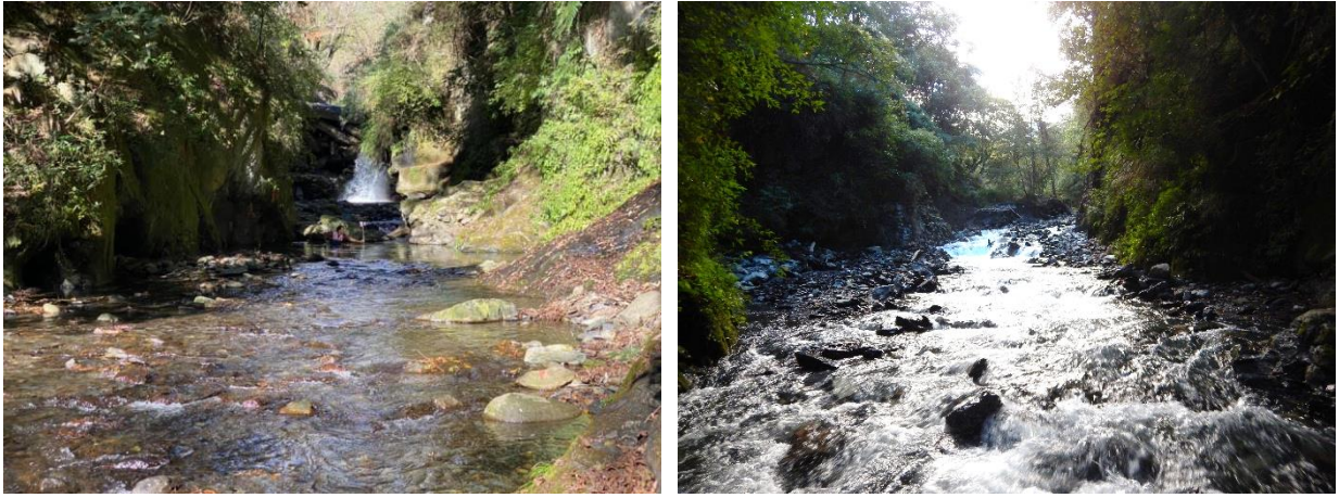
圖 1-7 施工前(左)、後(右)之高山溪二號壩下游河道照片
