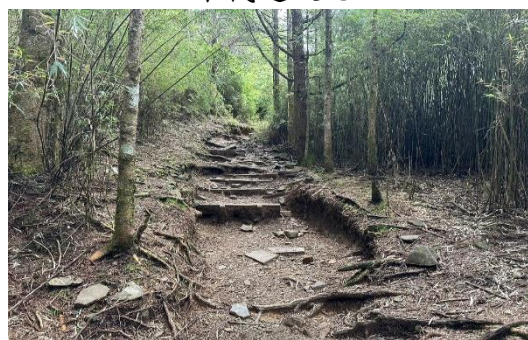
階梯擋土設施與周邊樹根關係
