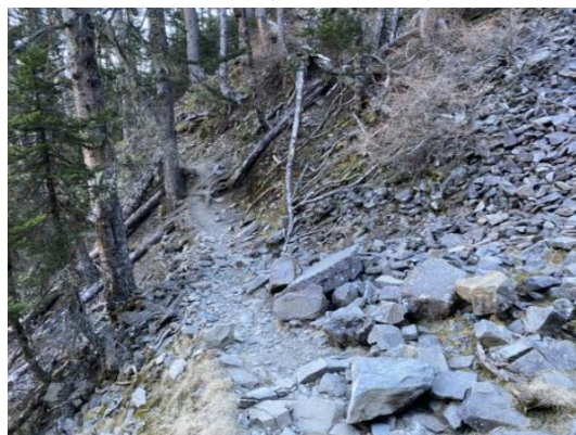
8.7K / 鋪設路緣石25m 2 土袋3層30個
