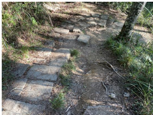
0.3K/鋪設路緣石2.5m 2
