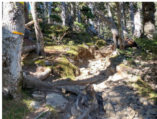
9.0K / 鋪設路緣石 45m 2
