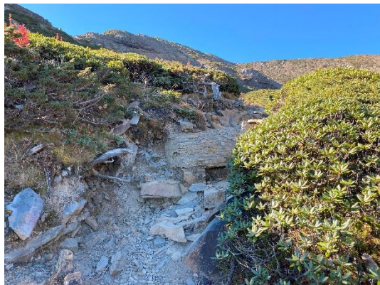
10.15K / 鋪設路緣石 25m 2
