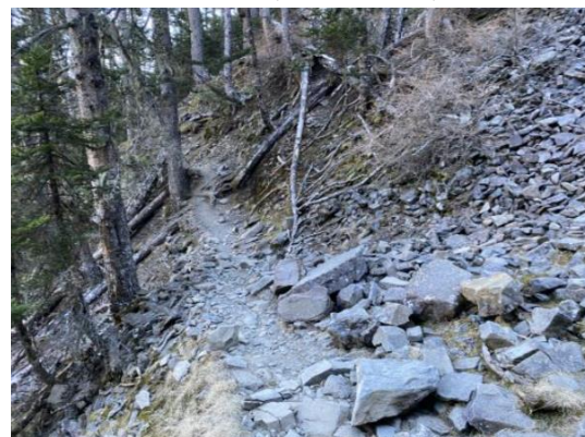
8.7K / 鋪設路緣石25m 2 土袋3層30個
