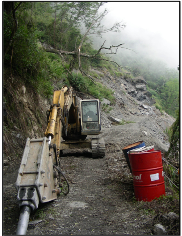
照片 3、大鹿林道東線 0.5K 施工後，淤積的土石與植被一併被移除（林雅玲攝）。
