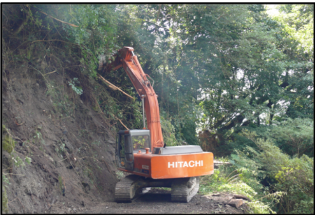
照片 4、大鹿林道東線 5.5K 路面流失路段，開挖上方邊坡以增加路面寬度，其邊坡及路面植被皆清除（林宗以攝）。
