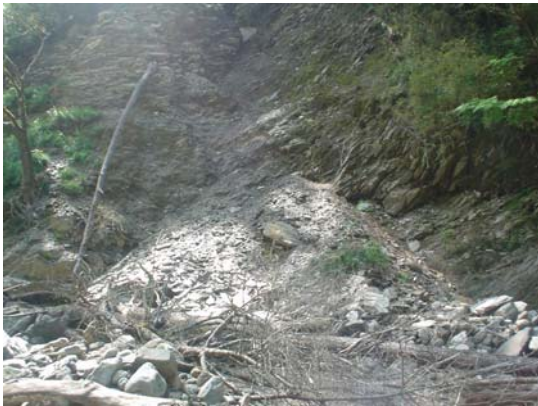
圖 3-37 七家灣溪五號壩上游崩塌
