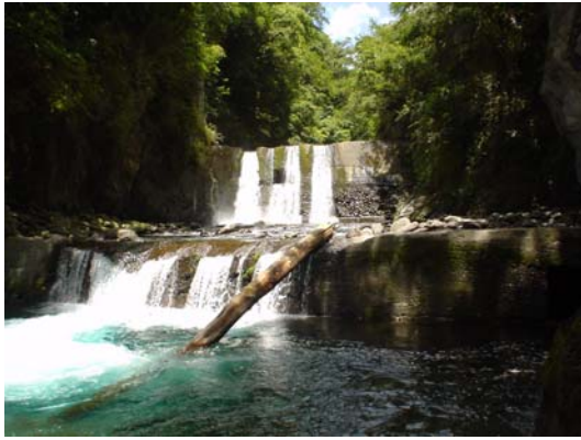
圖 3-40 七家灣溪四號壩全景
