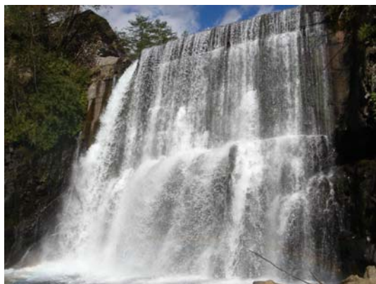
圖 3-45 七家灣溪三號壩正面照
