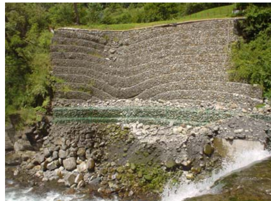
圖 3-56 右岸蛇籠工程
