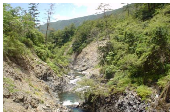
圖 3-60 三號壩下游崩塌
