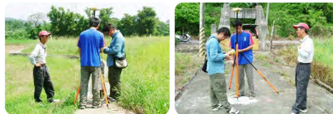
▲ 圖4-22 台電鐵塔用地預為分割實地測量情形
