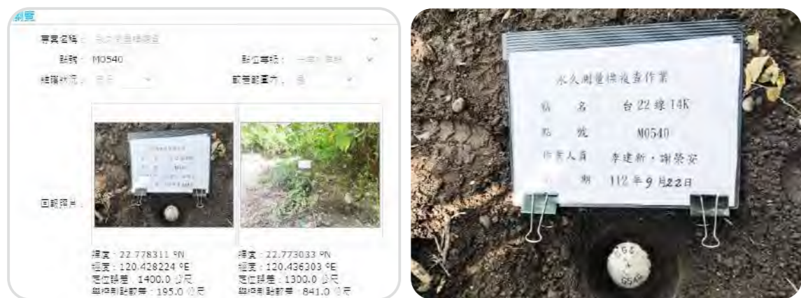
▲ 圖 4-10 永久測量標複查作業情形
