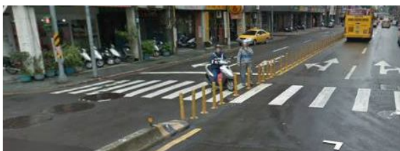
圖 11、具道路中央分隔設施(如：反光防撞桿)之道路中線繪製圖_道路中線儘量分隔繪製
