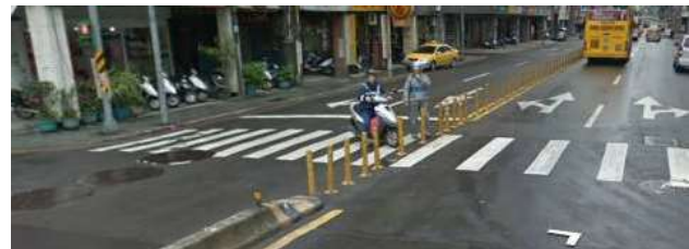
圖 11、具道路中央分隔設施(如：反光防撞桿)之道路中線繪製圖_道路中線儘量分隔繪製
