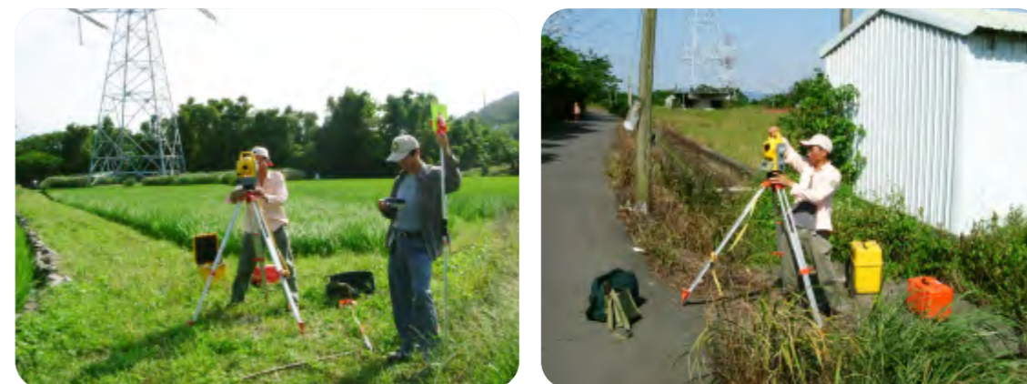
▲ 圖 4-28 台電鐵塔用地預為分割實地測量情形
