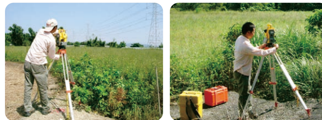
▲ 圖4-25 台電鐵塔用地預為分割實地測量情形
