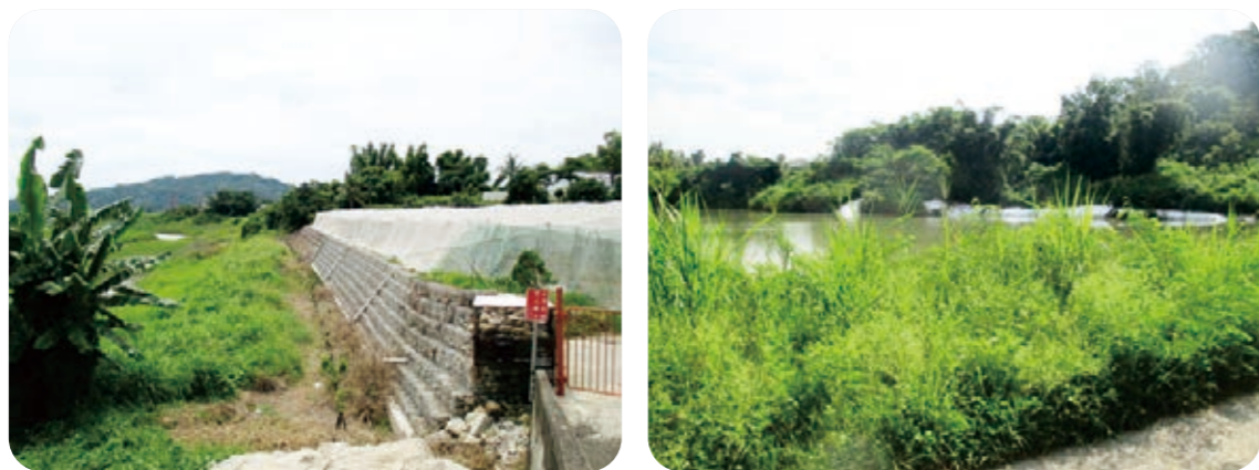
▲ 圖4-28 水庫集水區保育實施計畫巡管作業情形
