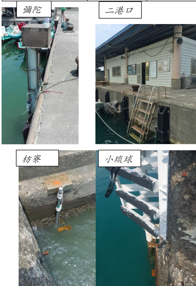
圖 3- 47 彌陀、二港口、枋寮以及小琉球潮位站架設情形
