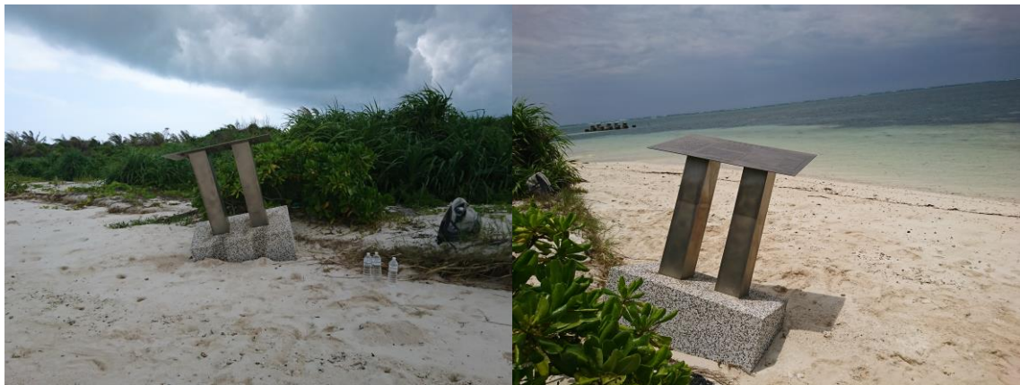
圖 4 D1 西北角 D2 東沙北角標示牌傾斜基石裸露情形
